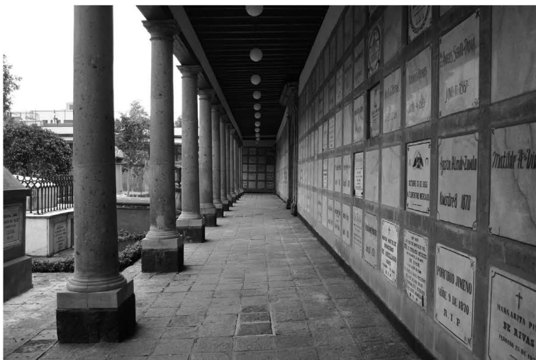
Fachada del Panteón de San Fernando. FUENTE: Google Images
