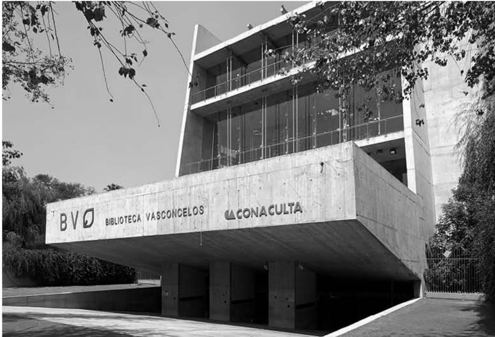
Acceso vehicular de la Mega Biblioteca José Vasconcelos. FUENTE: Google Images
