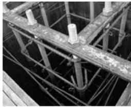
Producción de base de anclaje antes del llenado con cemento, Eje Central, México DF, 2015.
