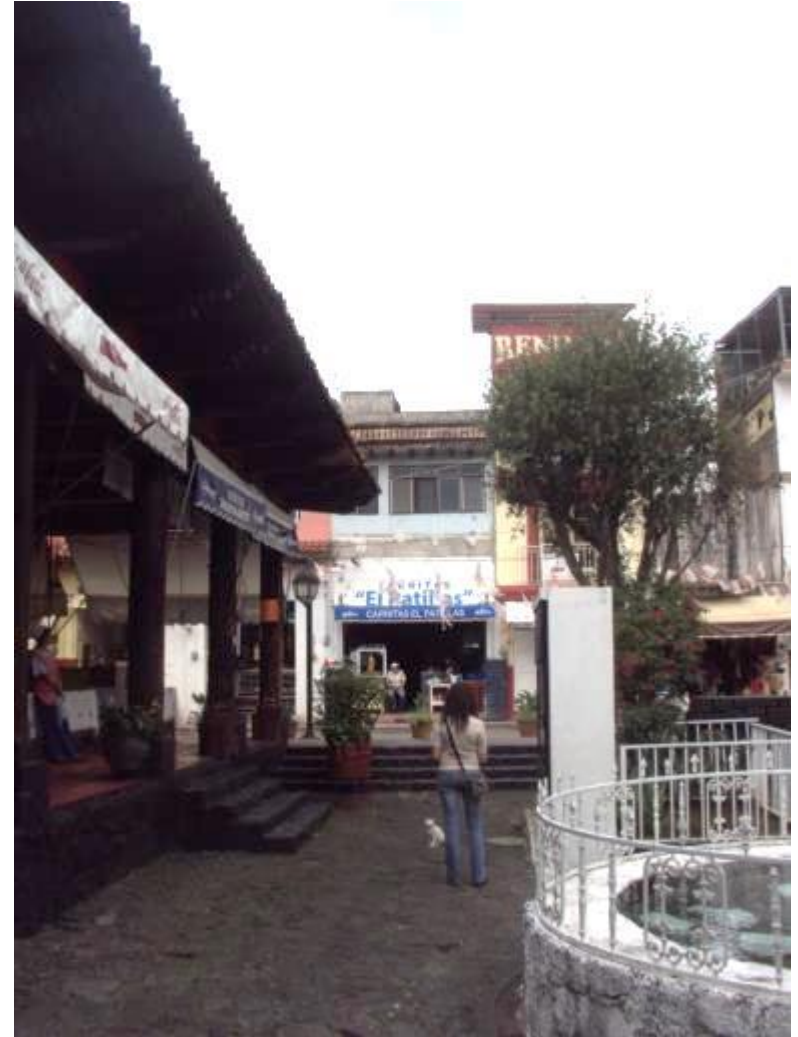
Fotografía del patio perteneciente al mercado de antojitos, este espacio permite una adecuada ventilación para el mercado entero así como un lugar para el acomodo de los cilindros de gas y surtidores de agua.
