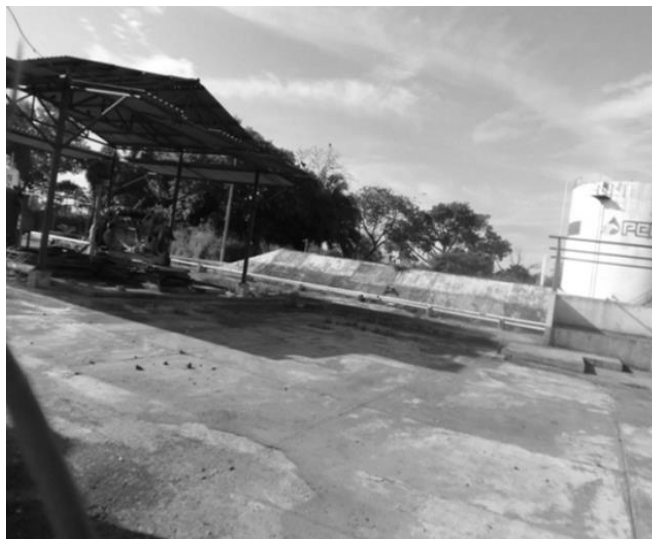
Batería de separación Carrizo en desmantelamiento
