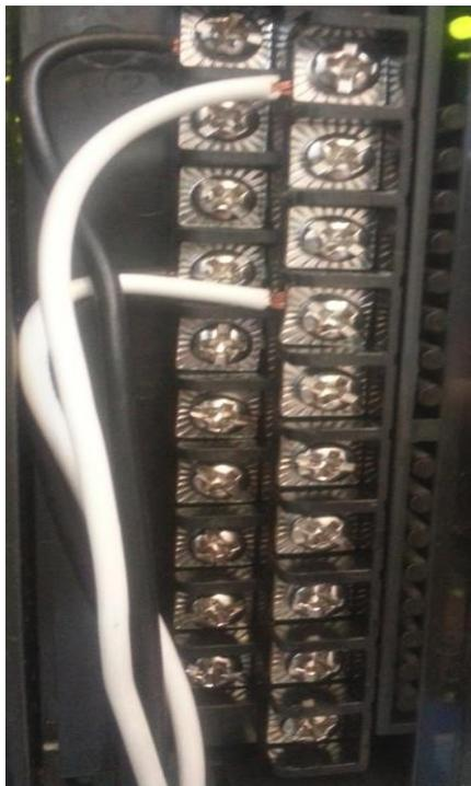
*Figura 4.38. Alambrado de la tarjeta de salidas analógicas para el control de la válvula 34PC01.*
