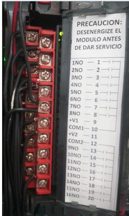
*Figura 4.33. Tarjeta de salidas digitales para habilitar las válvulas de vacío EV-1 y EV-2 a 24V.*
