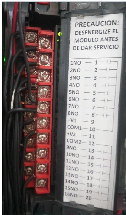
*Figura 4.24. Tarjeta de salidas digitales para habilitar los relevadores de estado sólido a 24V.*
