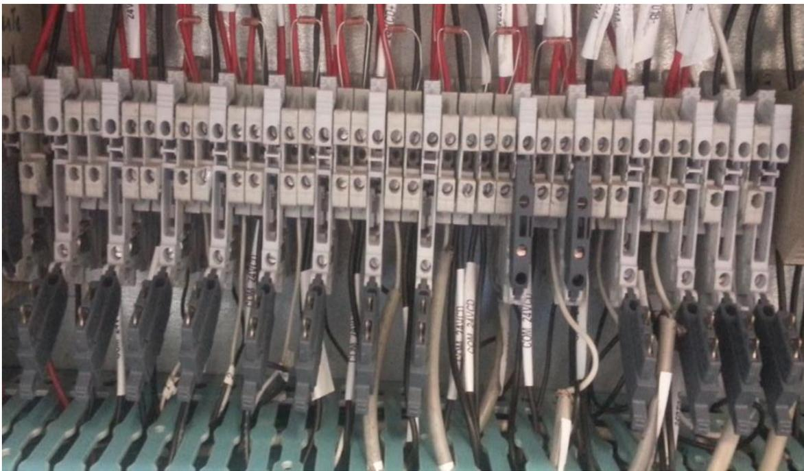
*Figura 4.17. Conexión de los transmisores de presión.*
