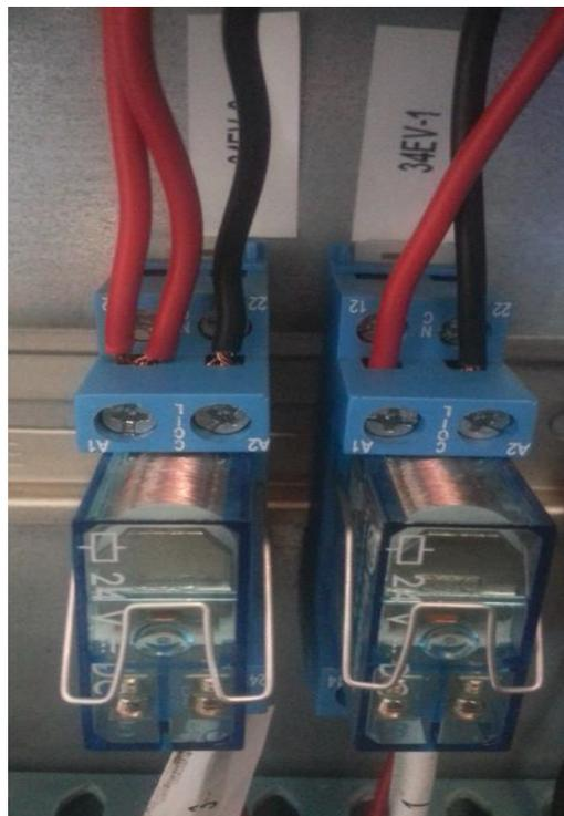
*Figura 4.34. Relevadores de 24V para habilitar las válvulas de vacío EV-1 y EV-2.*
