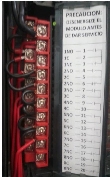
Figura 4.27. Tarjeta de salidas digitales que habilitan a los electroimanes a 120VCA.
