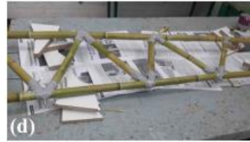
(a) Cortado de los carrizos al tamaño que se necesita; (b) Carrizos cortados al tamaño para hacer el subensamble; (c) Presentación del subensamble antes de sujetar con hilo; (d) Subensamble terminado con resina en los nodos.
