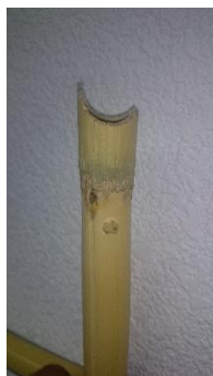
Figura 3.1.1.4.- Corte en carrizo tipo “boca de pescado”.
