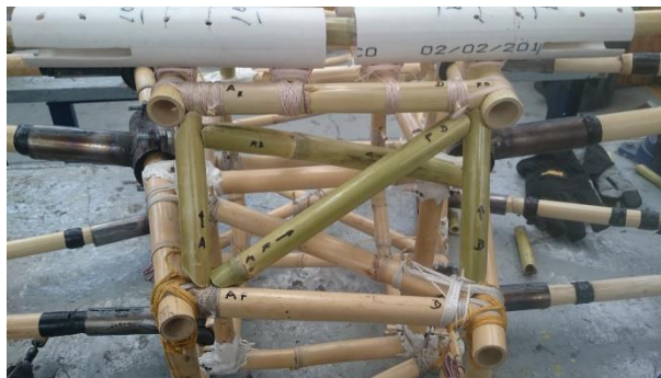
Figura 3.1.1.14.-Los carrizos verdes son los que formaron parte de la estructura para la suspensión.
