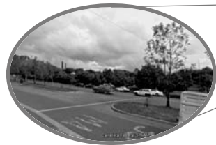
2.- VISTA DE LA INTERSECCIÓN DEL LIBRAMIENTO ORIENTE Y EL CAMINO VIEJO A LA COFRADÍA
