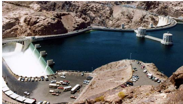
Fig 6. Ejemplo de vertedor de canal lateral en la Presa Hoover. Arizona, 1983.
