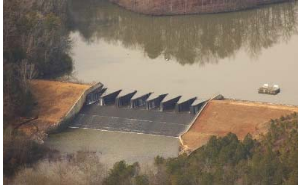
Fig 40. Rápida en la Presa Dog River, Condado de Douglas, Georgia. Fuente: www.panoramio.com
