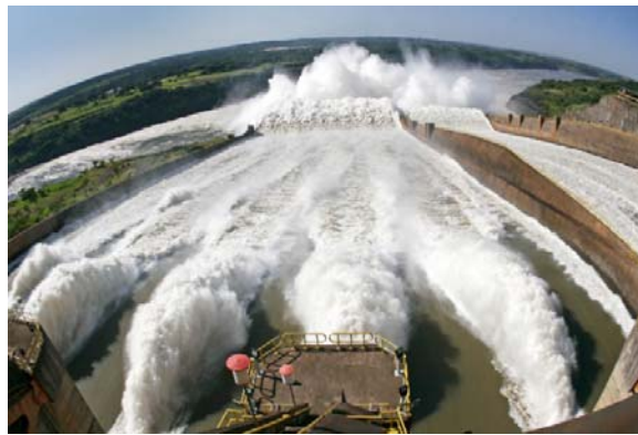
Fig 41. Desarrollo de las olas transversales en la rápida. Hidroeléctrica Itaipú. Brasil-Paraguay. Vista aguas arriba. https://adrianobattazza.wordpress.com
