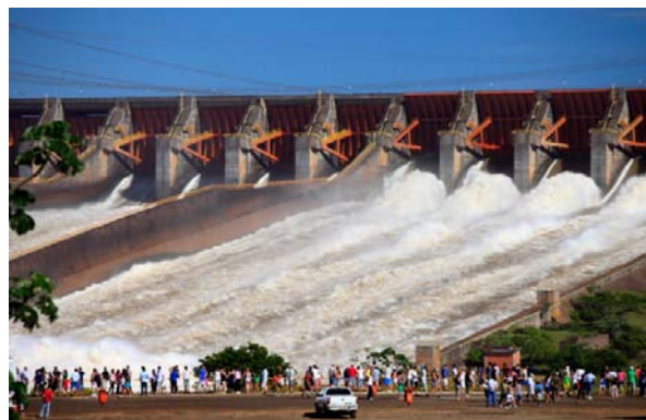
Fig 42. Desarrollo de las olas transversales debido a pilares y compuertas. Hidroeléctrica Itaipú. Brasil-Paraguay. Vista panorámica. https://www.turismoitaiipu.com.br
