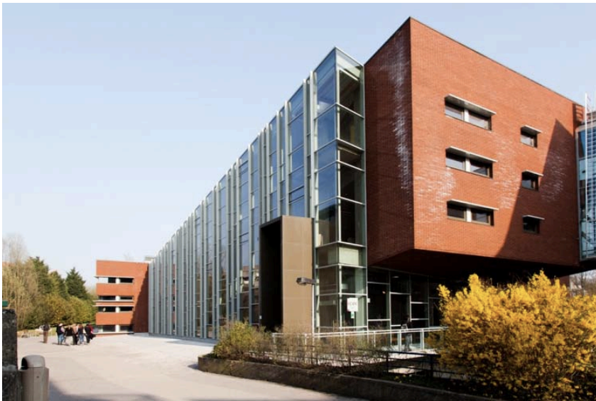
Vista Fachada, Instituto Técnico. 1
