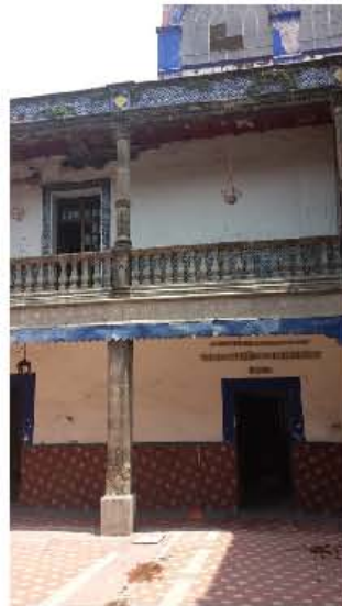
Imágenes tomadas en el interior del inmueble.
