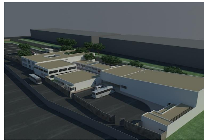
Fachada noreste, área de descarga y servicios.
