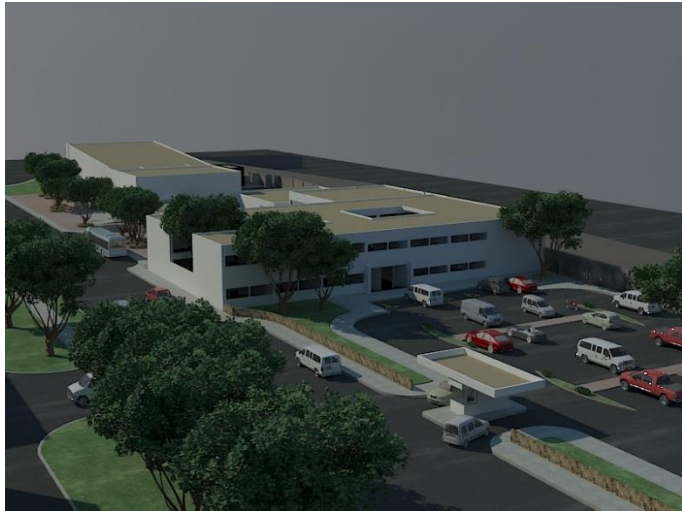
Fachada suroeste, Paseo Gral. Lázaro Cárdenas.
