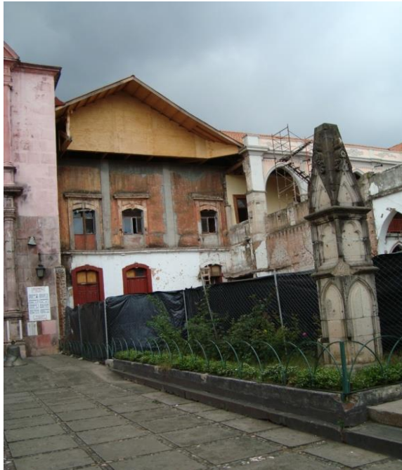
Fachada lateral de la Casa de la Cultura, la cual está siendo restaurada.
