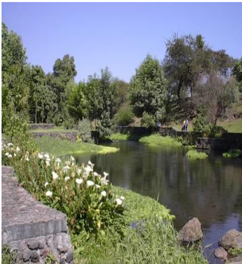
Presa de Caltzontzin
