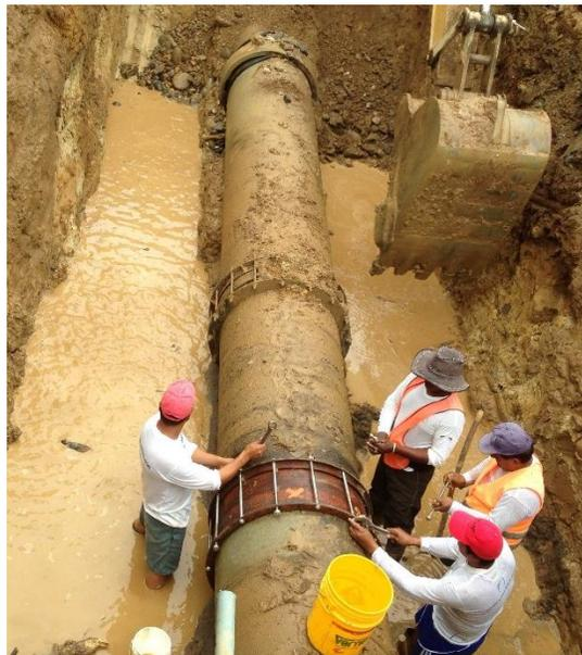
**Figura 1.3. Conducción de agua potable con tubería de asbesto-cemento en Ecuador.**
