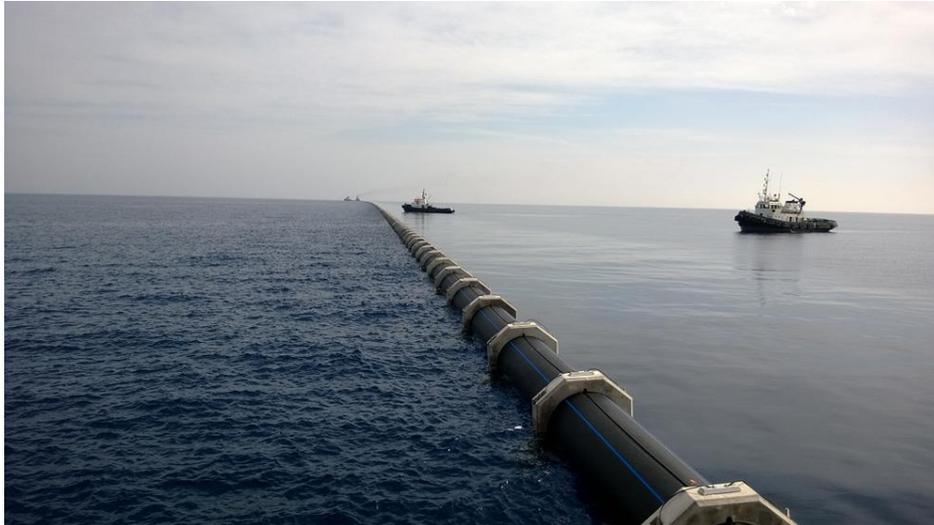
**Figura 2.5. Tubería de HDPE como emisor submarino.**
