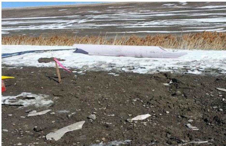
**Figura 4.14. Tubería de PVC de 16" con RD 31 – Salt Lake City, UT
