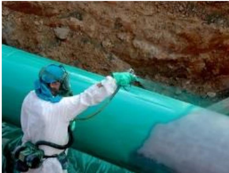
**Figura 1.10. Colocación de revestimiento externo a una tubería de acero.**
