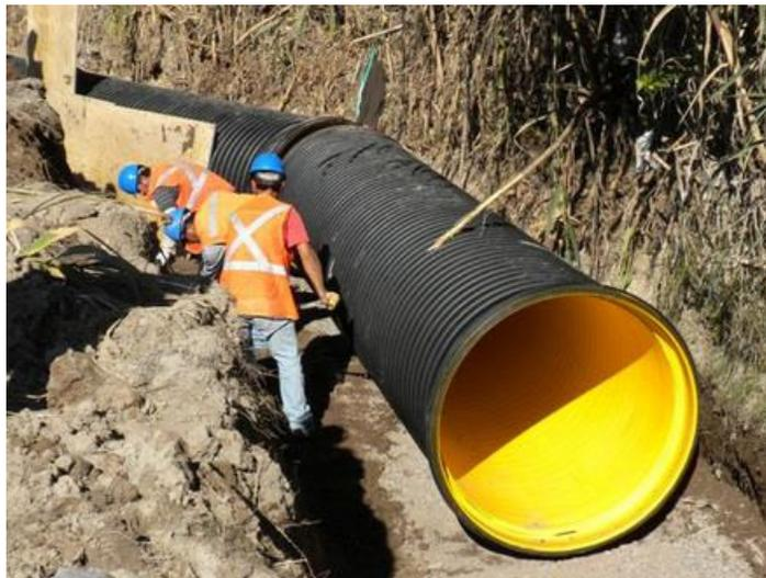
**Figura 2.6. Tubería de polietileno reticulado con pared interna lisa.**
