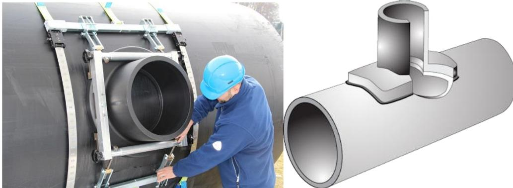
**Figura 2.13. Soldadura de sileta.**
