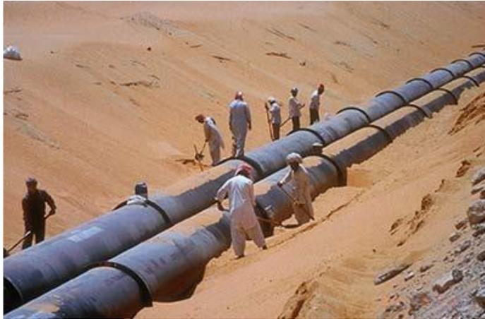
**Figura 1.2. Conducción de agua potable conformada con dos tuberías de hierro.**
