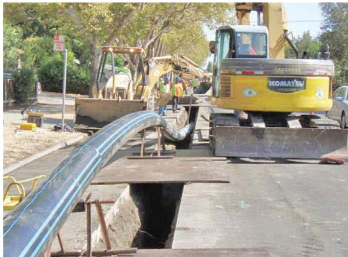
**Figura 2.4. Tubería de HDPE.**
