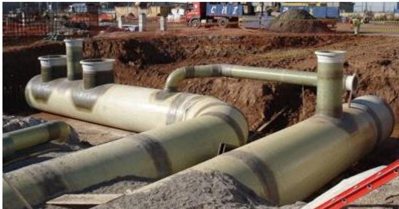
**Figura 1.7. Tuberías de plástico reforzado con fibra de vidrio.**
