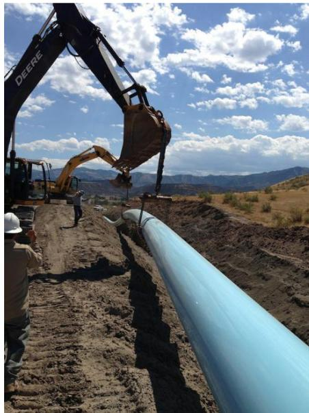
**Figura 2.2. Tubería de PVC tipo fusible.**
