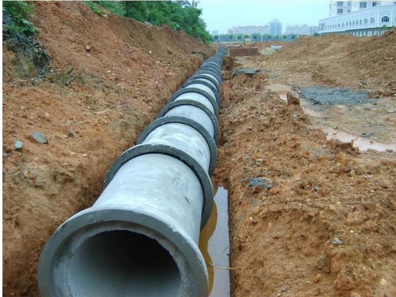
**Figura 1.4. Tubería de concreto con junta tipo espiga-campana.**
