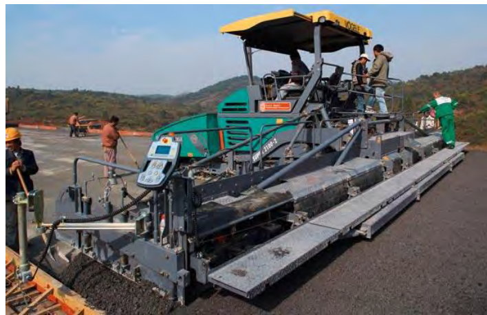
FIGURA 2.3.7- TENDIDO DE LA CARPETA ASFÁLTICA
