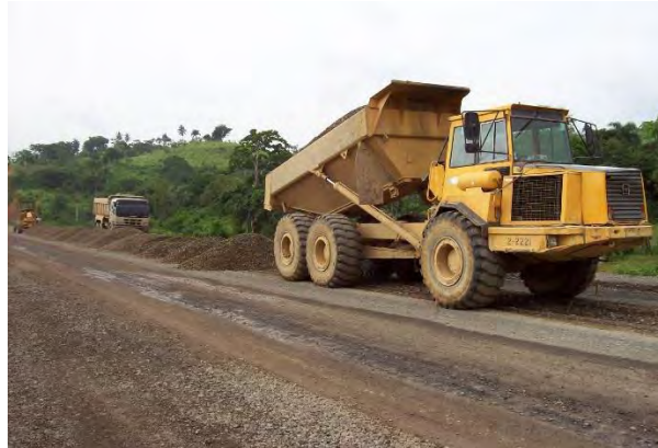
FIGURA 2.3.5- TENDIDO DE LA BASE
