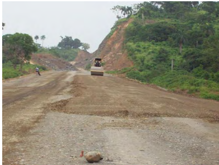
FIGURA 2.3.4- TENDIDO Y COMPACTACIÓN DE LA SUBBASE
