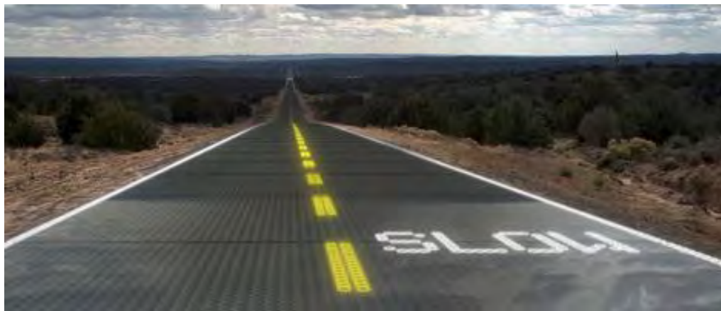
FIGURA 5.12. PROYECTO DE CARRETERA SOLAR.
