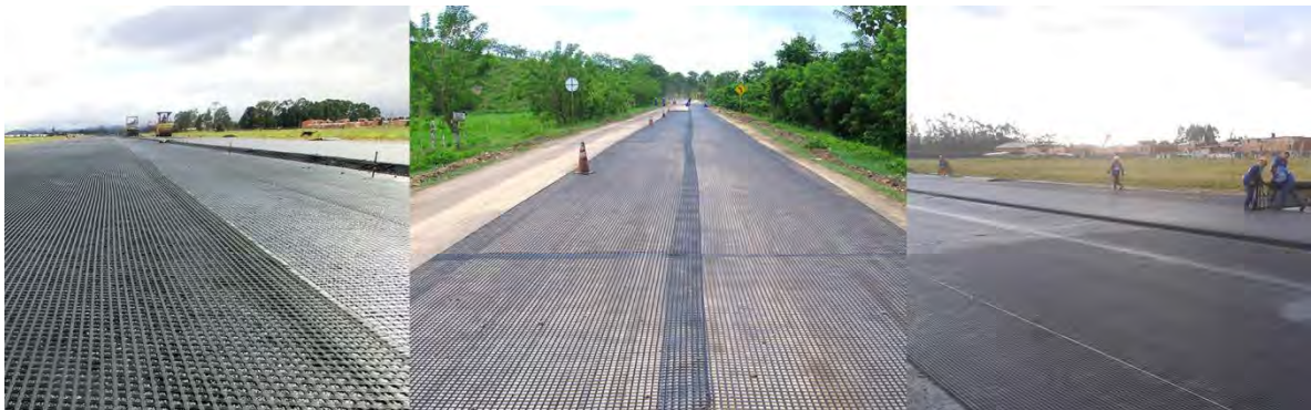
FIGURA 4.8.- INSTALACIÓN DEL GEOSINTÉTICO
