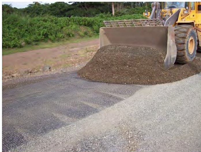
Figura 2.3.2- COLOCACIÓN DE GEOSINTÉTICO
