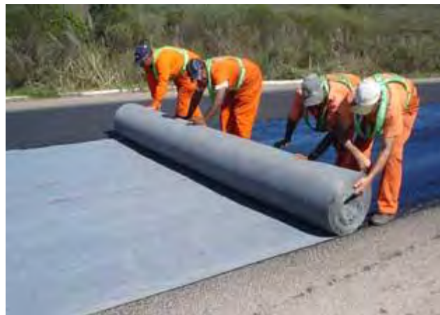
FIGURA 4.6.- COLOCACIÓN DE GEOTEXTIL
