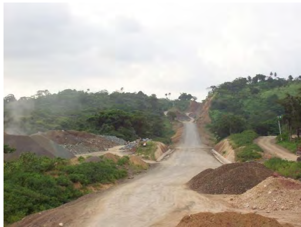
FIGURA 2.3.3.- TENDIDO DE GRAVA CEMENTADA SOBRE LA SUBRASANTE
