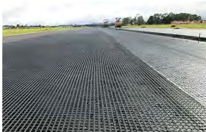
FIGURA 4.7. COLOCACIÓN DE GEOMALLA EN LA ESTRUCTURA DEL PAVIMENTO FLEXIBLE
