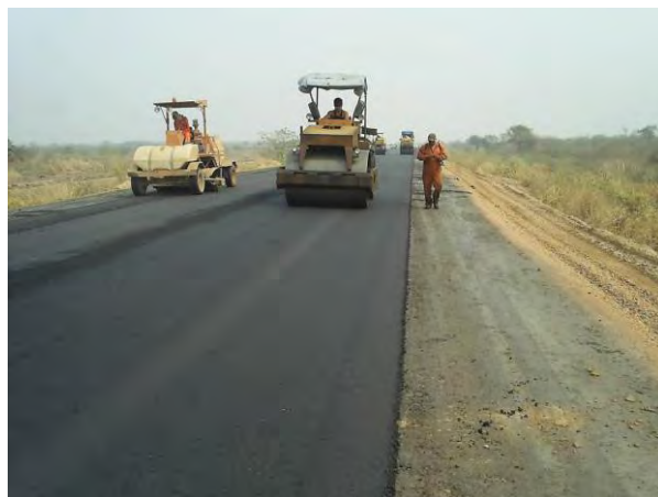
FIGURA 4.1- COMPACTACIÓN DE CARPETA ASFÁLTICA (CASAA)
