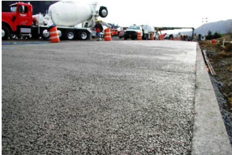
El pavimento de concreto permeable reduce el impacto de la erosión en los desarrollos que generan los escurrimientos y recarga los mantos acuíferos.
