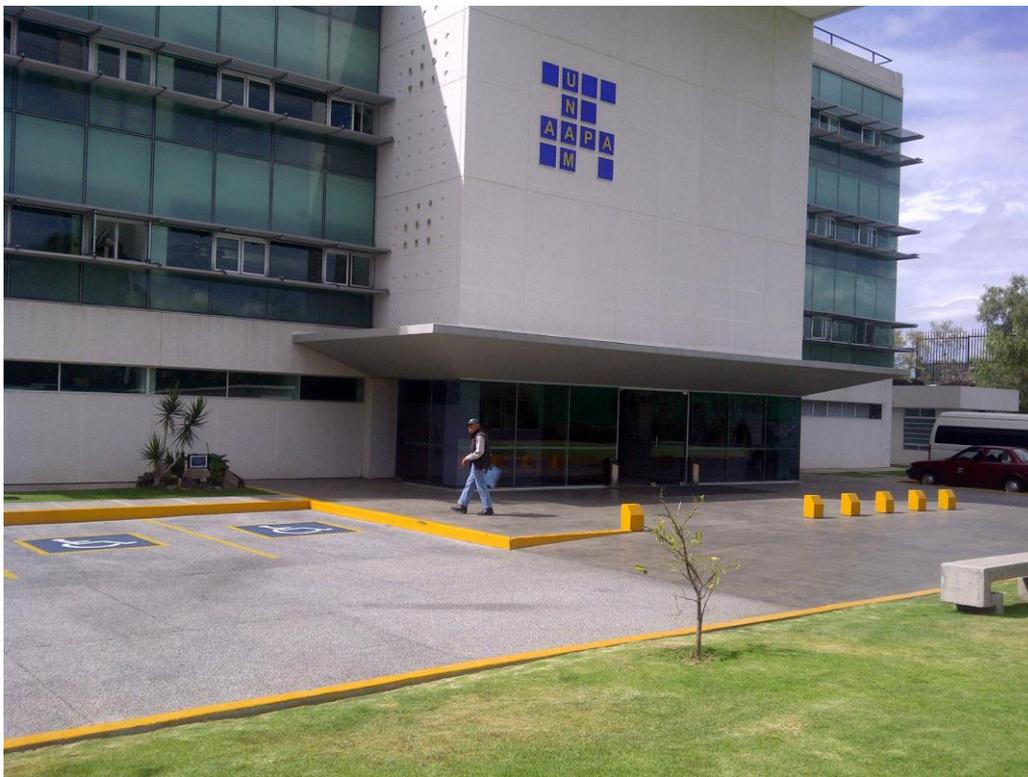
En esta imagen # 1, se muestra el edificio de la AAPA UNAM, con su estacionamiento frontal sin techar, construido con concreto permeable. Este edificio también cuenta en su parte trasera con un estacionamiento techado y en su parte baja el piso es de concreto permeable, el cual se mostrara en la imagen #2, así como andadores construidos también con concreto permeable para conectar las diferentes áreas de la AAPA UNAM.
