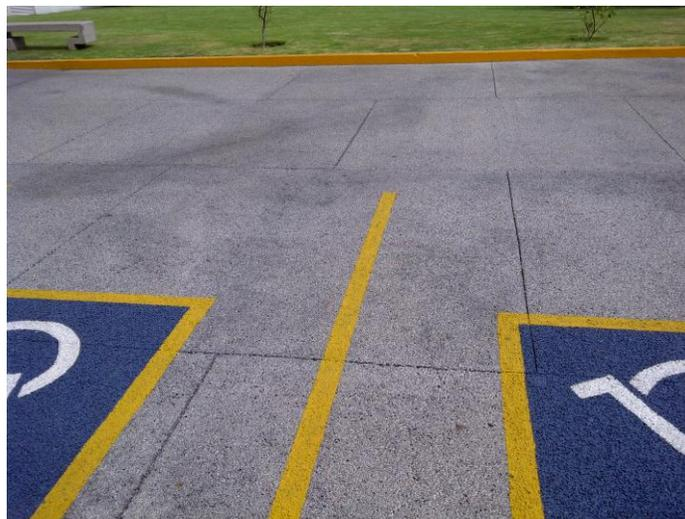
En esta imagen (imagen # 5) se puede apreciar que en este caso los cortes de junta de contracción en el concreto están a cada 2 metros, en ambos sentidos.
