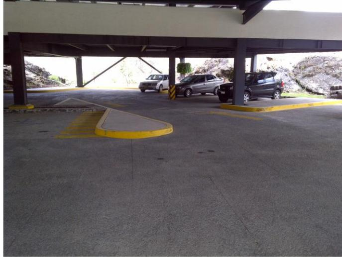
En la imagen # 2 se puede apreciar otra parte del estacionamiento de la AAPA UNAM, este estacionamiento es de 2 pisos, pero en su planta baja, el piso está construido con concreto permeable, se puede apreciar que no existe ningún tipo de coladera para recibir las aguas producidas por los escurrimientos, ya que todo se filtrara a través del concreto permeable.
