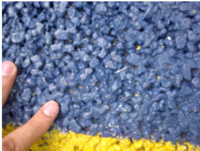
Ahora podemos apreciar en la imagen # 3, la porosidad que presenta el concreto permeable, principal característica por la que permitirá el filtro del agua a través de él. Este acercamiento es tomado del concreto permeable que se encuentra en el estacionamiento sin techar, la pintura es para señalar que es un espacio designado para personas con necesidades especiales.
