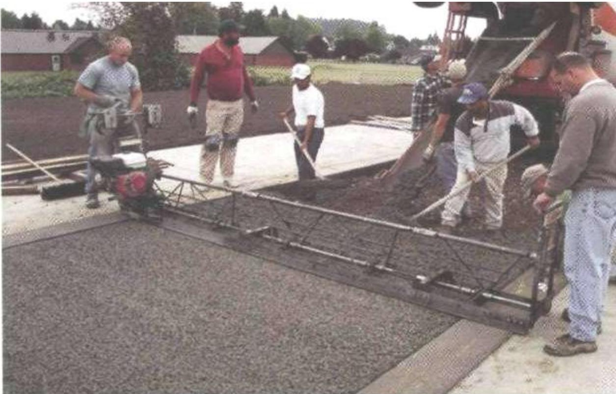
4. Si el concreto presentara características con exceso de pasta o revenimiento, el material se debe de dejar reposar por un tiempo aproximado de 10 min.
