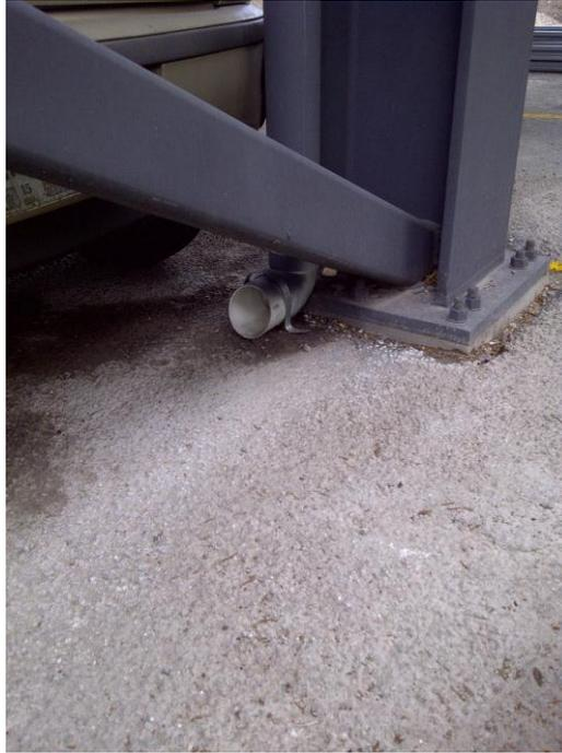
Aquí en la imagen # 4 se ve con claridad que los bajantes de aguas pluviales no están conectados a ninguna red de aguas pluviales o alcantarillado, sino que el tubo baja hasta la planta baja y se deja abierto para que el agua se filtre a través del concreto permeable, con esto se cumplen 2 de los objetivos del concreto permeable, que son la recarga de los mantos acuíferos y el evitar tener instalaciones para conducción de aguas pluviales.
