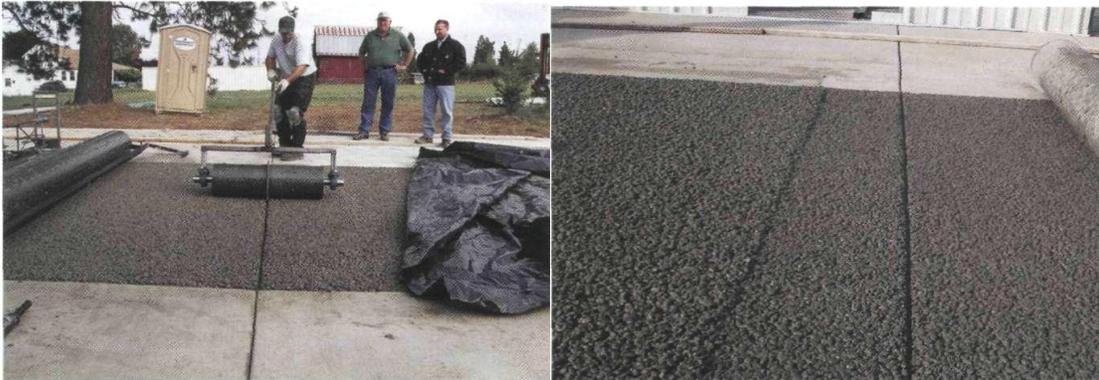
10. El proceso de vaciado, acomodo, compactación y cortes de juntas, debe realizarse en menos de una hora, esto debido a que si se llega a secar el concreto la adherencia del agregado en superficie puede ser débil, lo que provocará desprendimientos a futuro.
