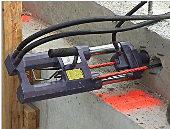
**Figura I.20** Gato hidráulico empleado para tensar los tendones
