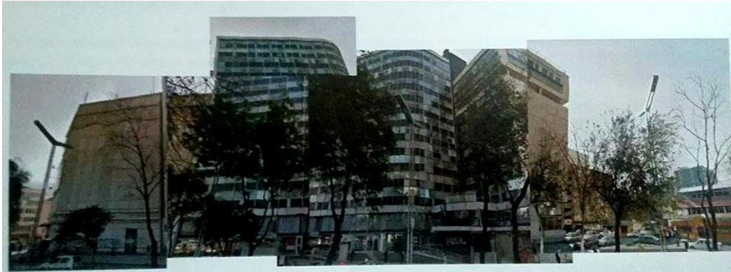
Fachada de Hotel Fontan
