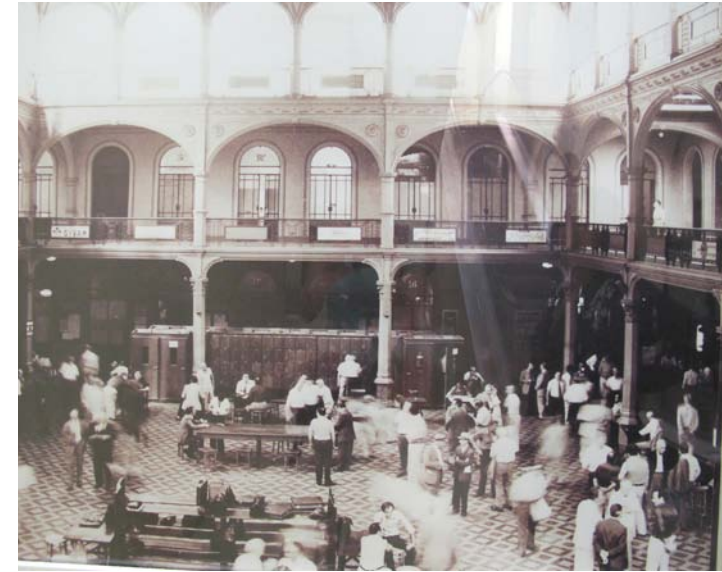
Foto de Interior de Sala Borsa. Archivo de la Universidad de Boloña, Italia.
