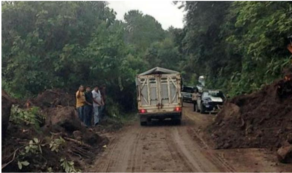
Figura 2.14. Bloqueo por deslizamiento en la carretera a Teziutlán – Nautla, (Fuente: Municipios Puebla, 2013).
