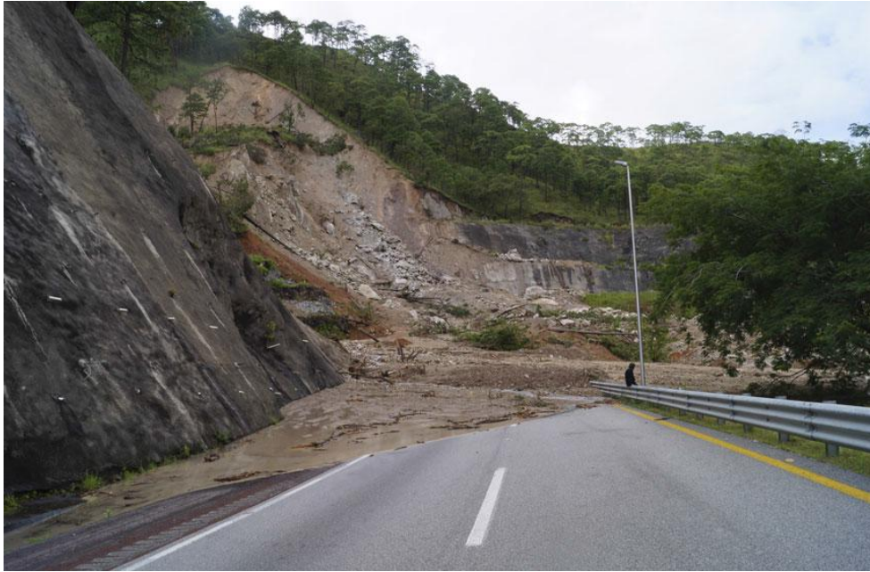
Figura 1.11. Deslizamiento en autopista del Sol (Fuente: Excelsior, 19 de Septiembre 2013).
