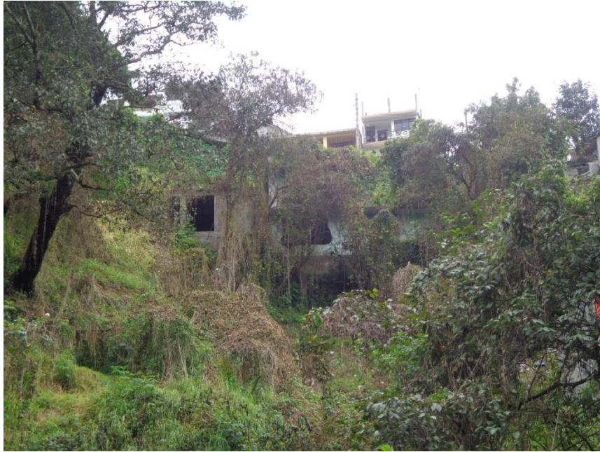
Figura 4.21. Casas abandonadas en la ladera de la colonia Juárez, Teziutlán.
