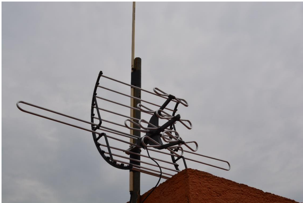
Figura 5-18 Antena direccional para televisión digital
