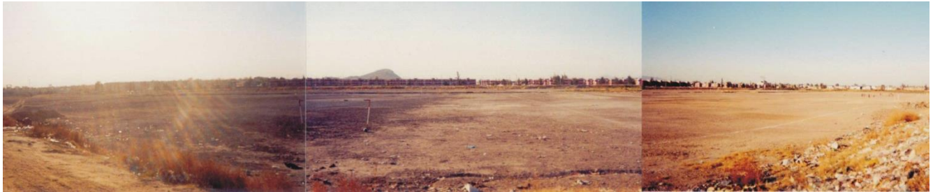
Foto F11. Vista general del predio, desde la calle José Ma. Gutiérrez, se aprecia el talud perimetral formado por tierra, cascajo y basura, al fondo se observan las Unidades Habitacionales colindantes y parte de los campos de fútbol amateur.
