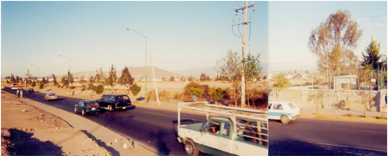
Foto F2. Vista general del predio, desde la Avenida Prolongación Octavio Paz, se aprecian las instalaciones colindantes de la DGCOH ( hoy SACM ), en su extremo sur poniente y la poca vegetación a lo largo de esta Avenida, teniendo un aspecto árido.
