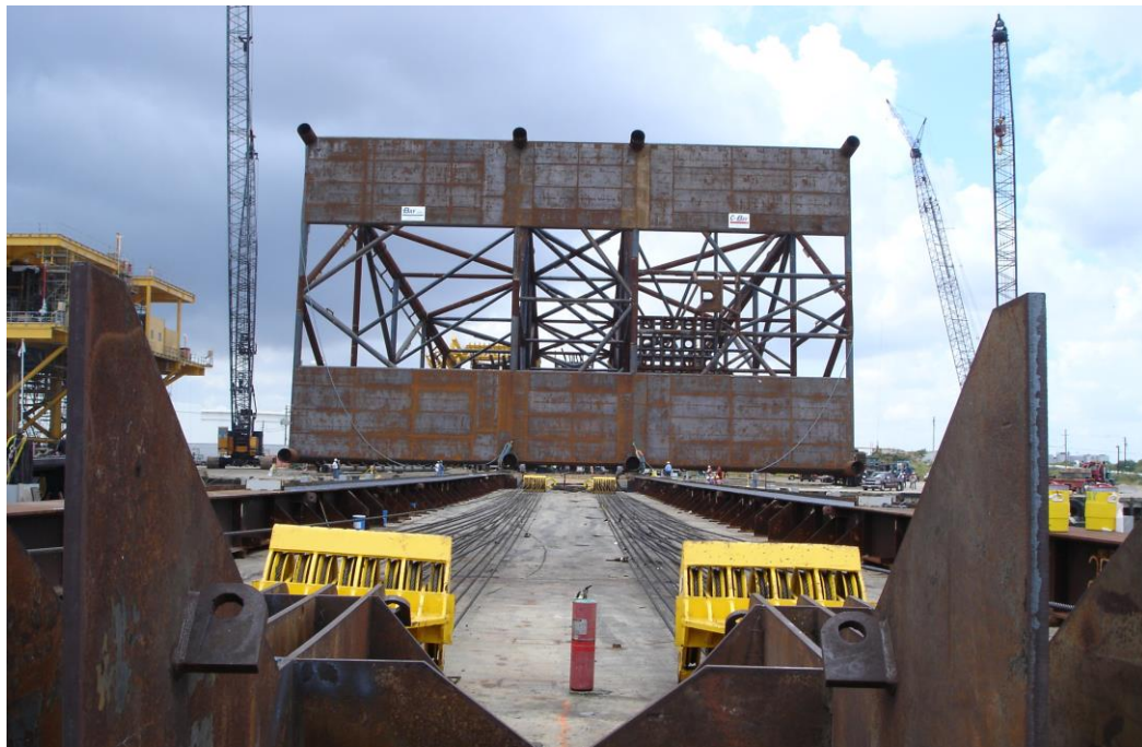
Figura 2.5. Placa Base en la Subestructura
