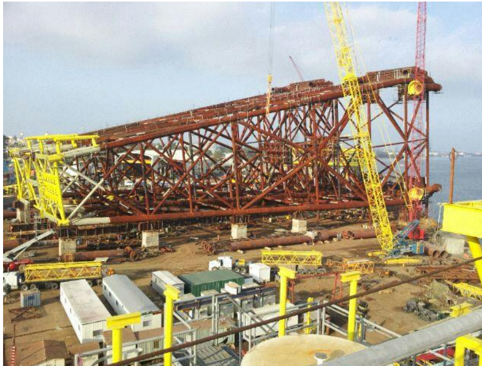
Figura 2.3. Subestructura (Jacket) de Ayatsil-D
