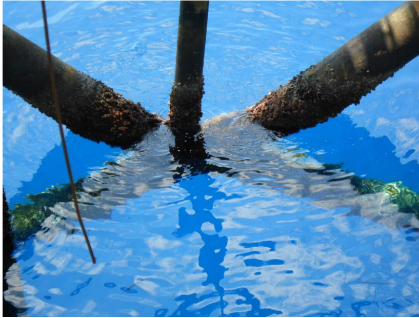
Figura 2.8. Crecimiento marino en los arriostramientos
