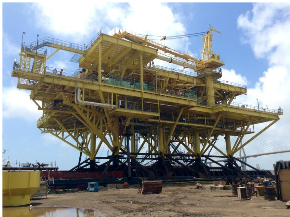
Figura 2.4. Superestructura (Deck) de Ayatsil-D
