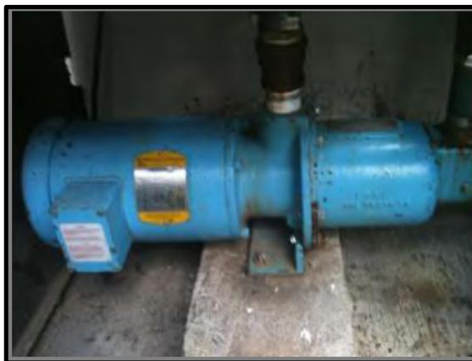
Figura 3.12 Bomba de alimentación y mezclado monyo Mod. 35651 (Grimaldo, 2013)
