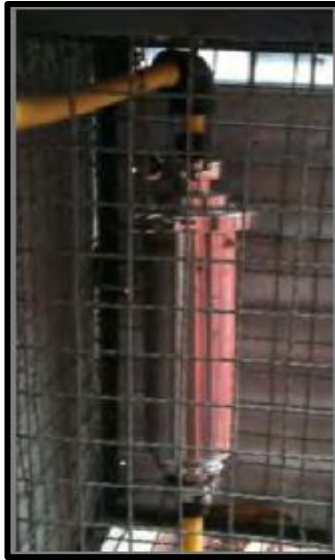
Figura 3.15 Desulfurador de biogás (Grimaldo, 2013)
