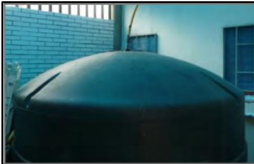
Figura 3.14 Segundo Reactor R-2 anaerobio (Grimaldo, 2013)
