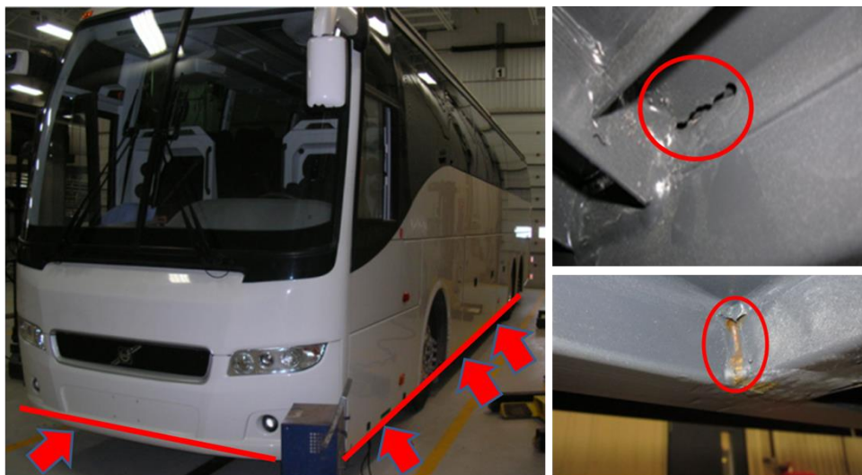
Figura 1.6 Defecto y falta de soldadura en plataforma baja
