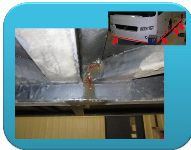
Figura 2.3 Soldadura mal aplicada bajo plataforma
