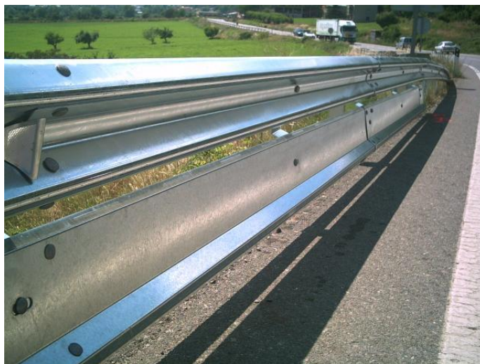
FIGURA 31-1 Barreras de protección, diseñadas para alargar su longitud a consecuencia de impactos.
