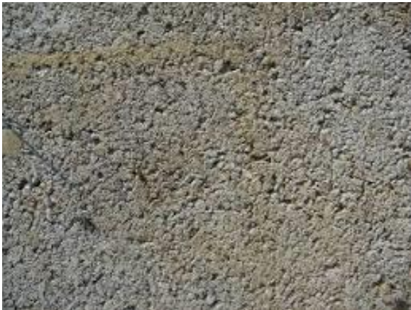
FIGURA 22-1 Hormigón poroso utilizado en estructuras
