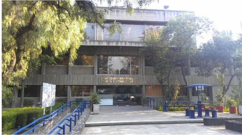
Figura 1. 9 Dirección General de Obras y Conservación - UNAM
