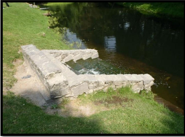
Llegada de agua de la PTAR al Quijote
