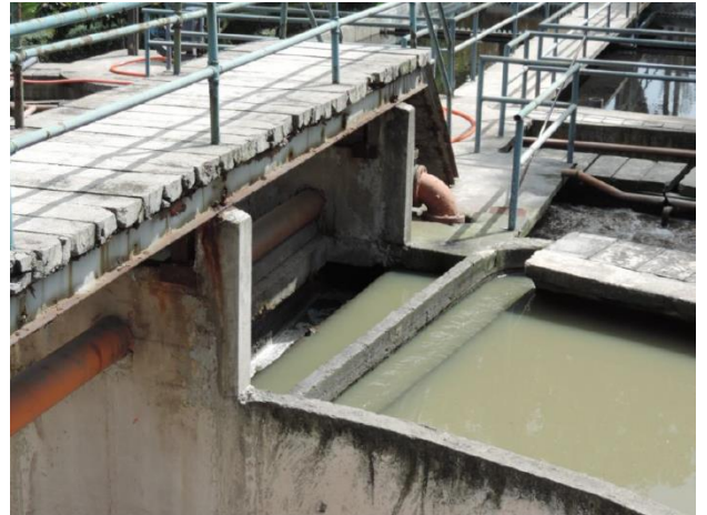
Fotografía 2. Vertedor sedimentador primario
