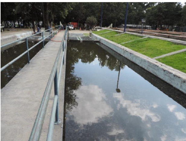
Fotografía 11. Sedimentador secundario
