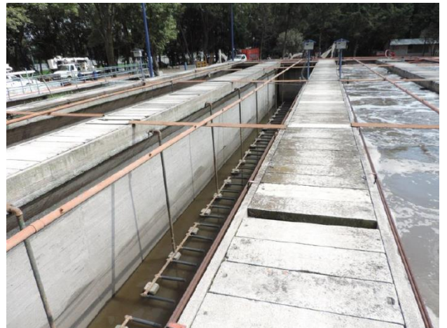
Fotografía 10. Muros de aireación
