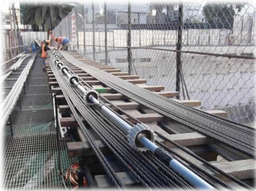
*Figura 37. Colocación de separadores de plástico.*
