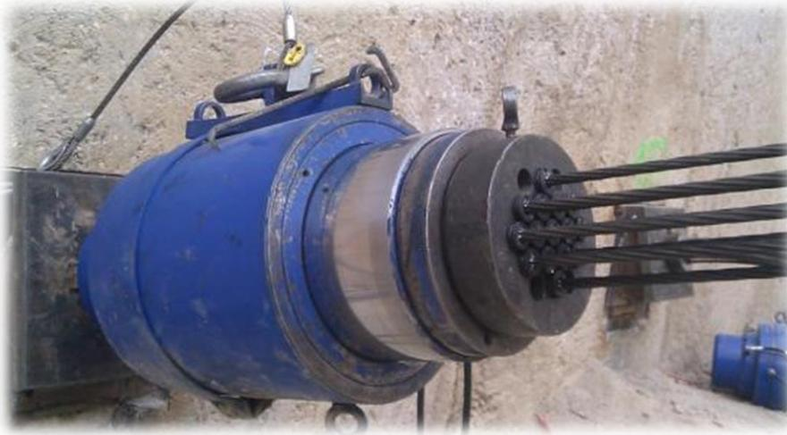
*Figura 73. Montaje de gato con capacidad para 15 torones.*
