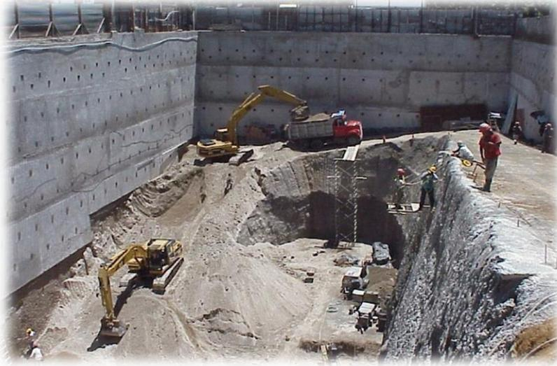
*Figura 2. Anclas como elementos de soporte sobre muro Milán.*
