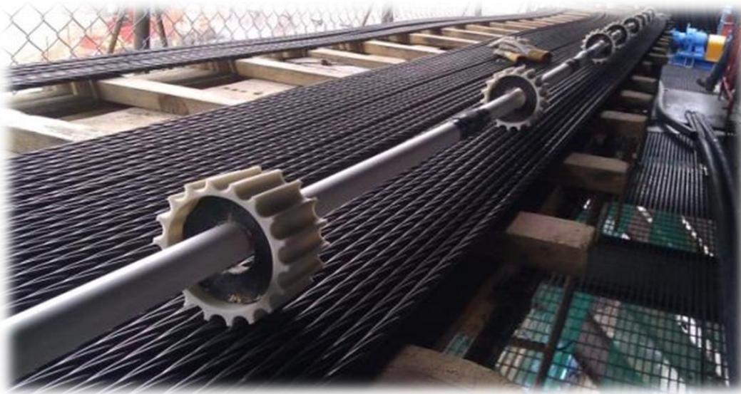
*Figura 47. Colocación de separadores de plástico.*
