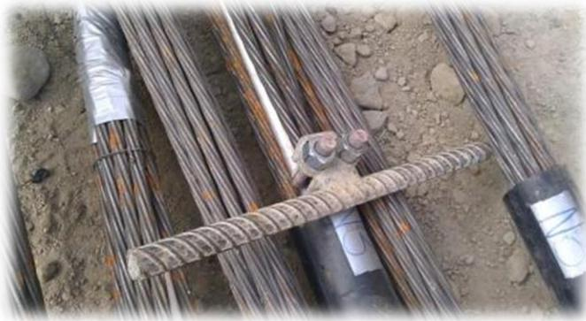
*Figura 43. Instalación de retenedores metálicos previo a la colocación del tirante dentro del barreno con el fin de sostener el tirante una vez dentro del barreno.*
