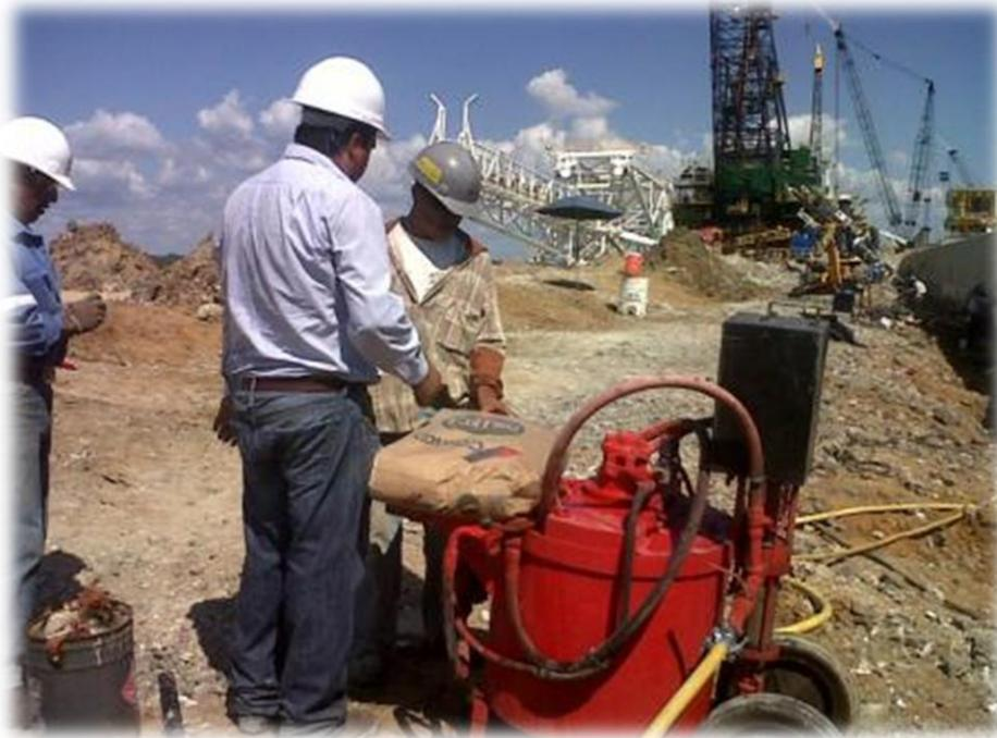
*Figura 82. Se fabrica la lechada para la parte libre del ancla para los trabajos de protección en anclas permanentes.*
