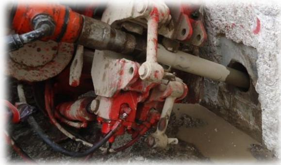
*Figura 56. Perforación rotatoria con broca cola de pescado*
