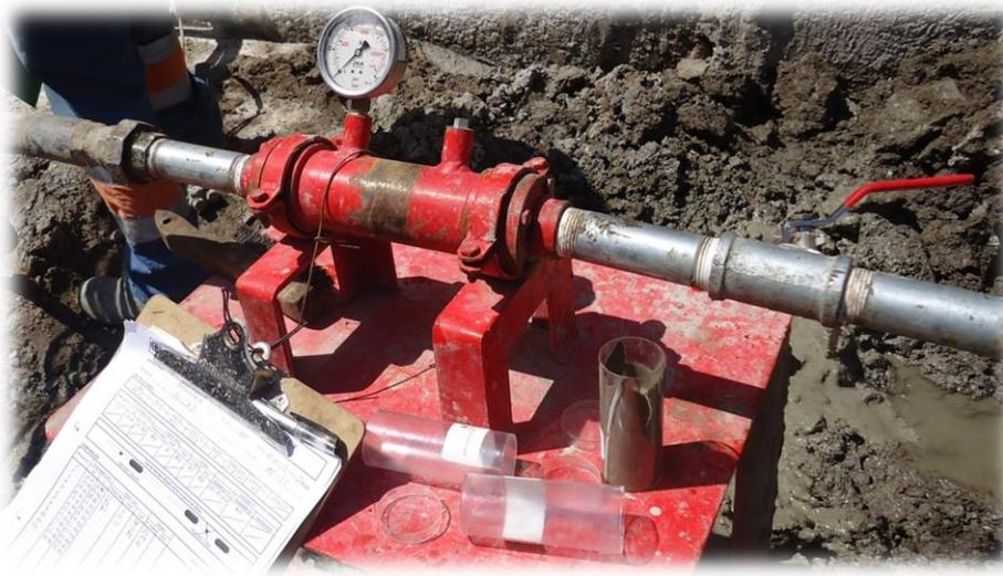
Figura 63. Banco con manómetro para tomar la presión de inyección.
