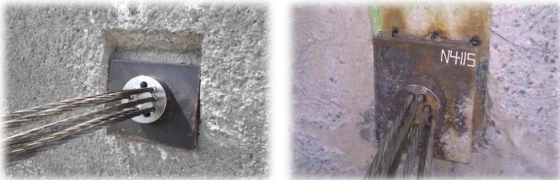
*Figura 72. Silletas y quesos ya instalados.*
