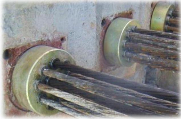
*Figura 67. Anclas tensadas.*
