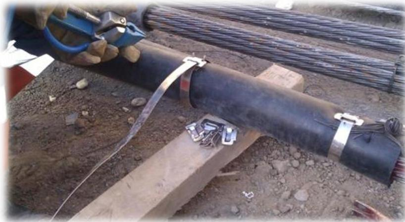
*Figura 41. Colocación de flejes.*
