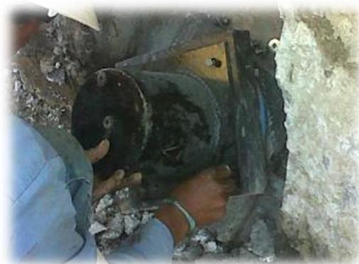
*Figuras 85. Capuchón y tubo trompeta empleados en la protección de anclas permanentes.*
