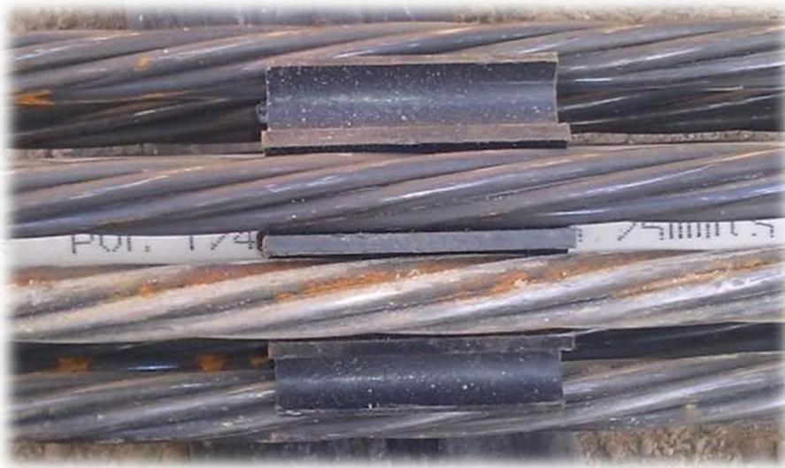
*Figura 38. Vista de separador instalado.*
