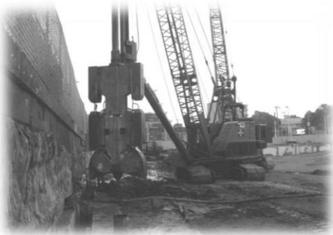
*Figura 17. Excavación de zanja con almeja.*
