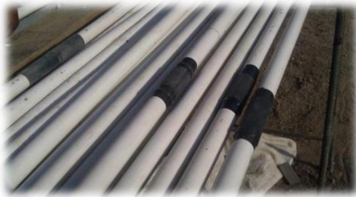
*Figura 36. Ejemplo de la instalación del tubo manguito sobre el PVC.*
