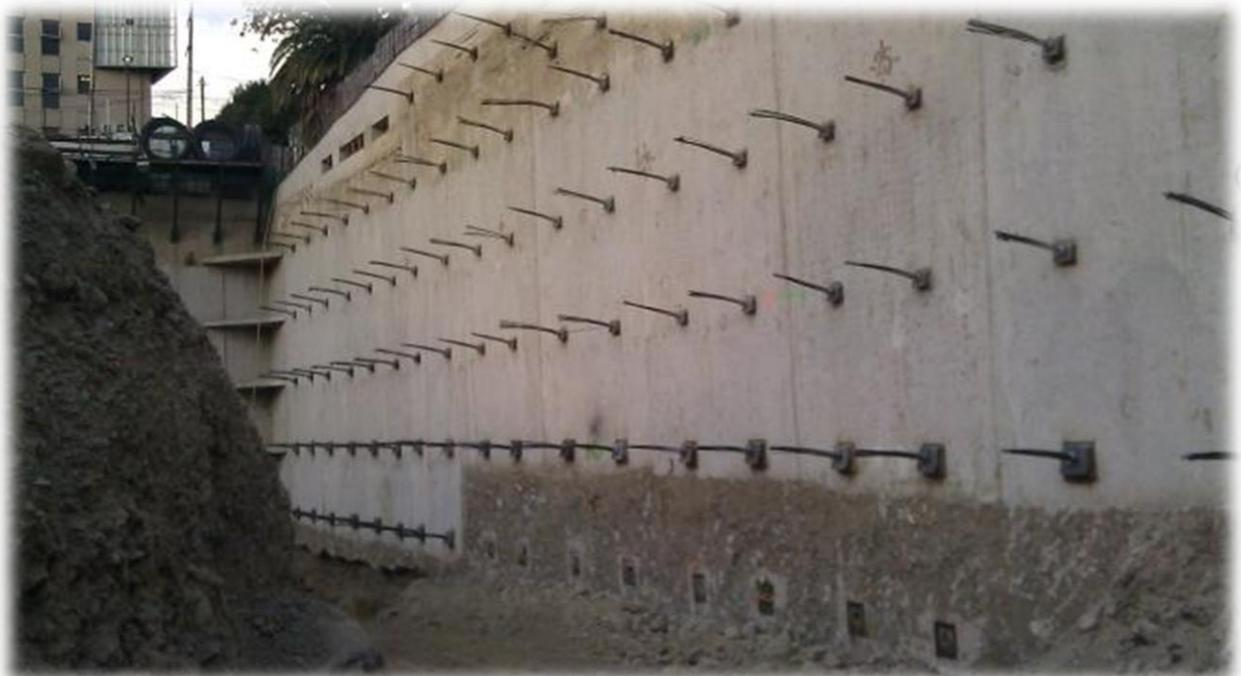
*Figura 25. Ejemplo de avance en un sistema de anclas activas para una excavación.*
