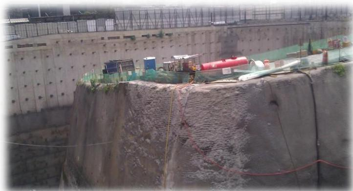
*Figura 21. Rampa de acceso a la excavación.*
