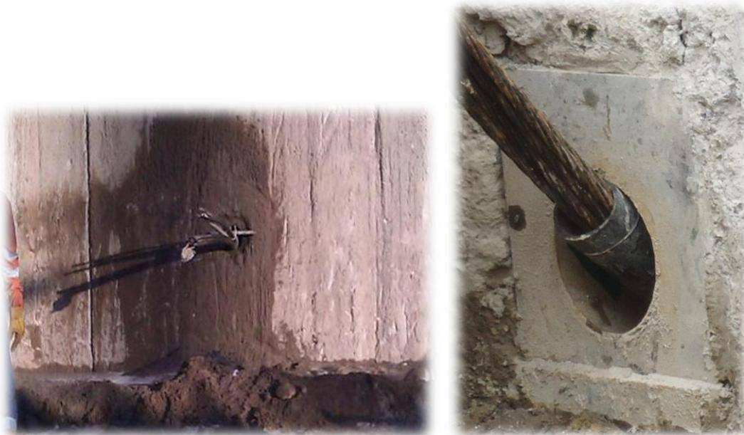
*Figuras 60. Ancla dentro del barreno.*
