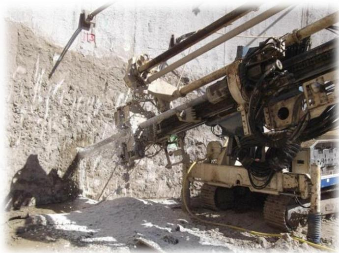
*Figura 55. Maquinaria perforadora SOILMEC SM-18 realizando trabajos de perforación en un muro Milán.*
