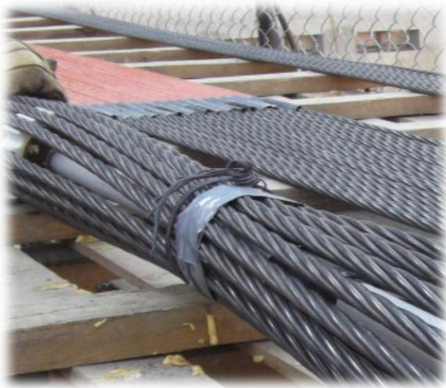
*Figura 11. Opresor metálico o fleje.*
