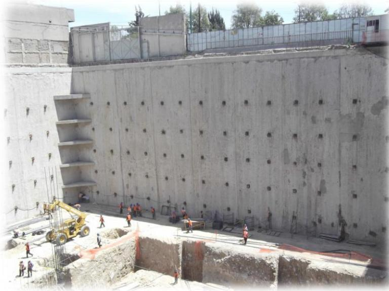
*Figura 22. Muro Milán y anclas para una excavación.*
