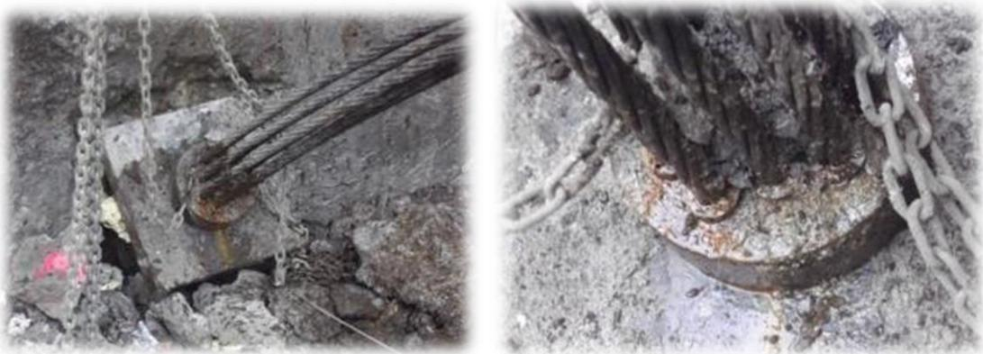
*Figuras 86. Corrosión en ancla temporal.*
