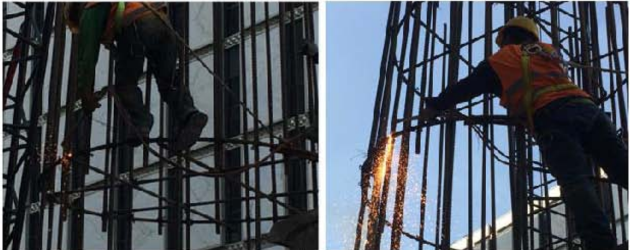
Fig. 3.31, Corte de Refuerzos Provisionales
