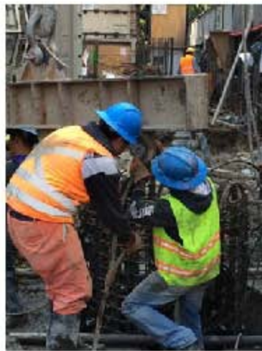
Fig. 3.34, Conexión de estrobos Internos al balancín y Tensado
