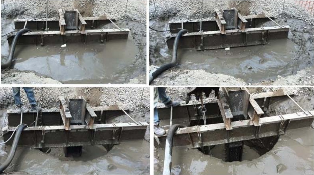
Fig. 4.26, Bombeo Exceso Lodo Bentonítico
