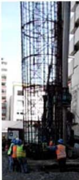
Fig. 3.23 y 3.24, Colocación del Armado inferior a la Perforación
