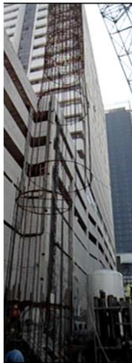
Fig. 3.29, Conexión Armado Superior con Inferior
