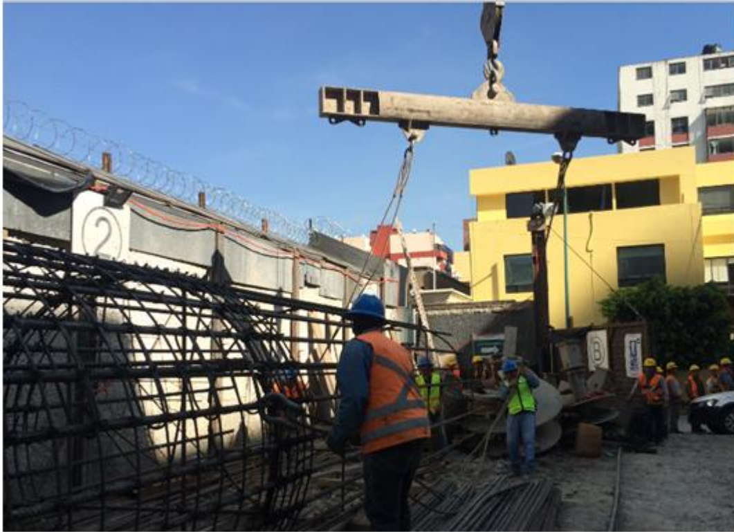
Fig. 3.15, Conexión Armado Inferior con el Balancín
