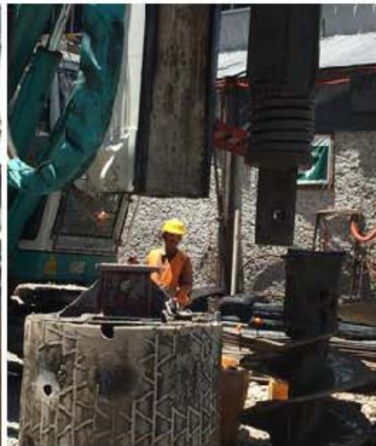
Fig. 2.34, Cambio de la Broca por el Bote
