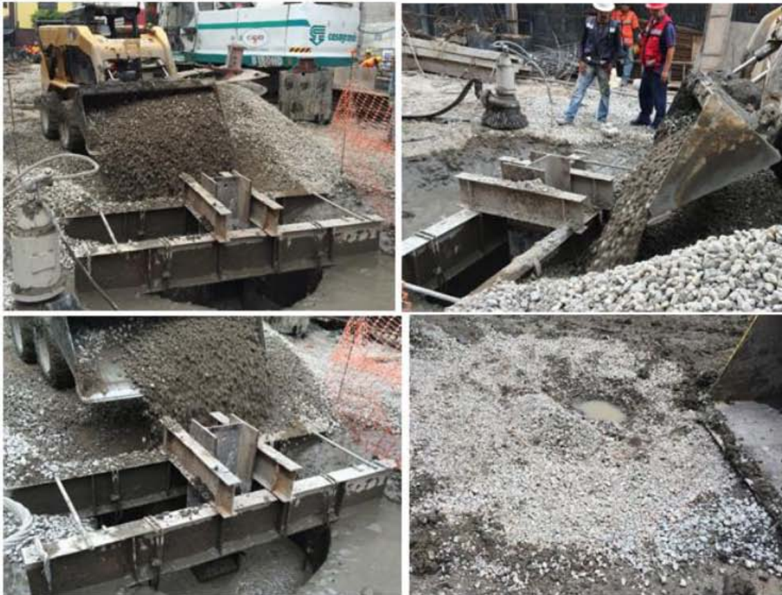
Fig. 4.27, Relleno de Perforación con Grava
