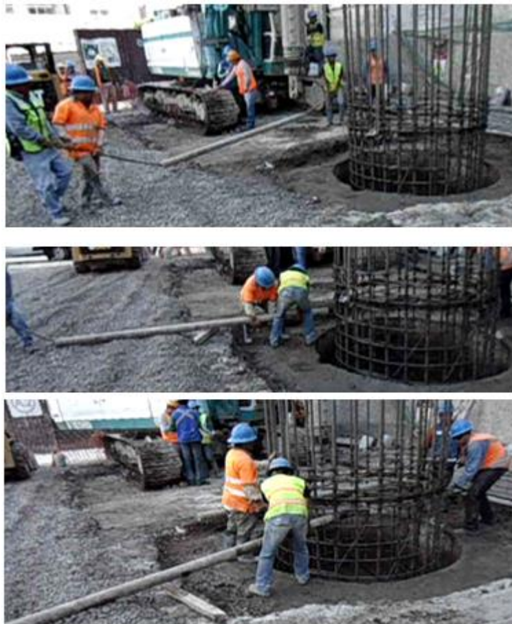
Fig. 3.25 Colocación de Tubos Metálicos para Trampeo
