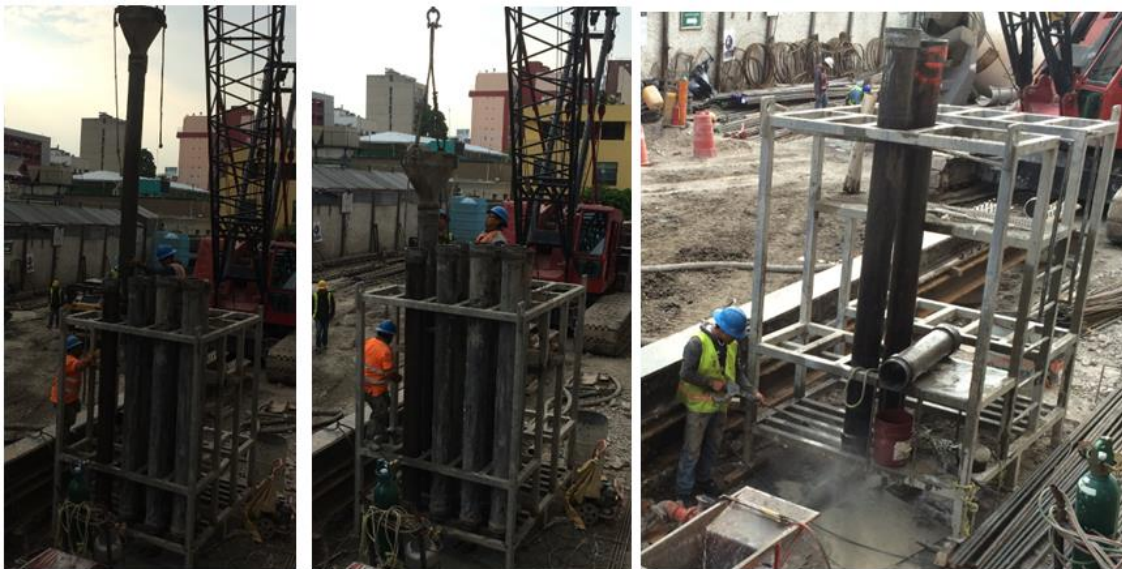
Fig. 4.22, Desarmado Tubería Tremie, Lavado Tubería Tremie
