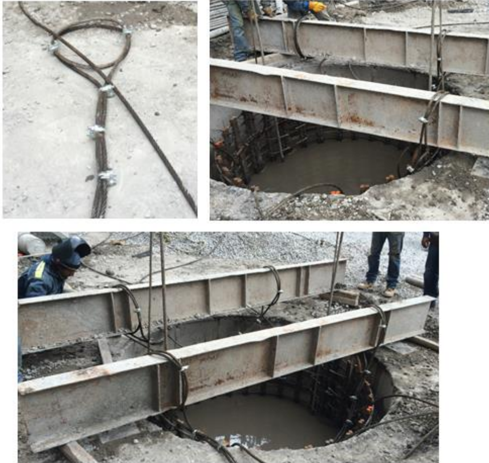
Fig. 3.21, Orejas y Trampeado Final
