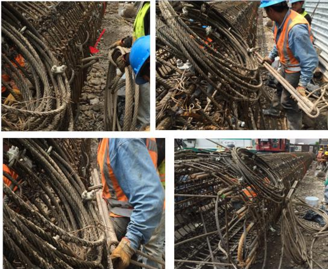
Fig. 3.19, Colocación de Ajuga en Estrobos Internos
