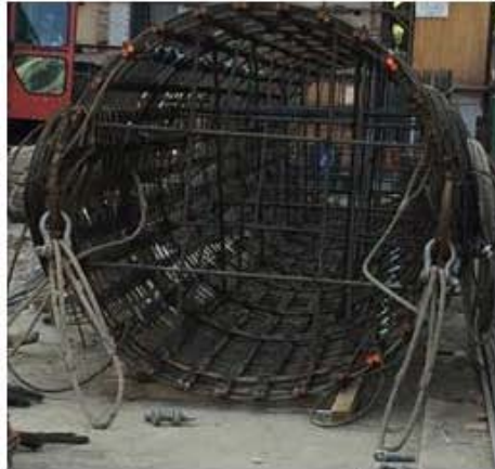
Fig. 3.26 Colocación de los grilletes y estrobos a las orejas de izaje
