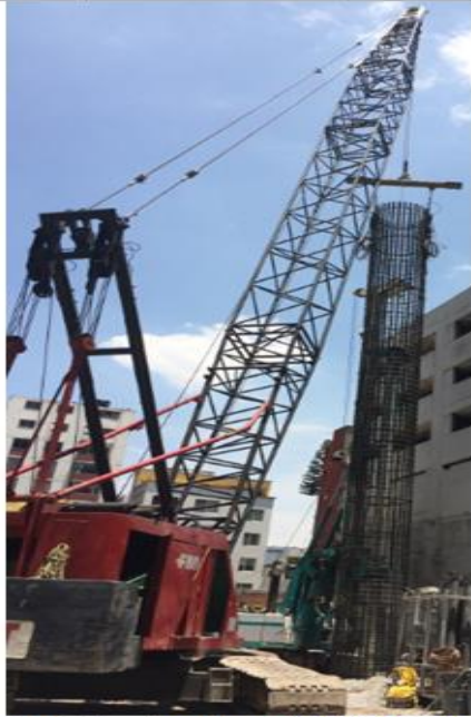
Fig. 1.23, Grúa sobre Orugas LINKBELT LS418A
