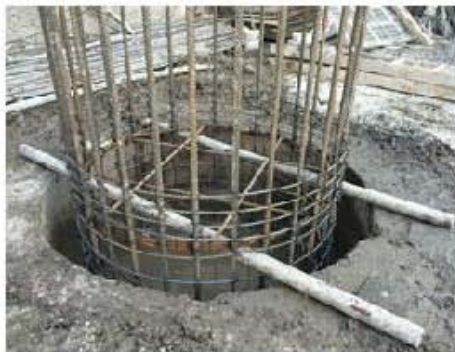
Fig. 3.27, Trampeo del Armado Inferior
