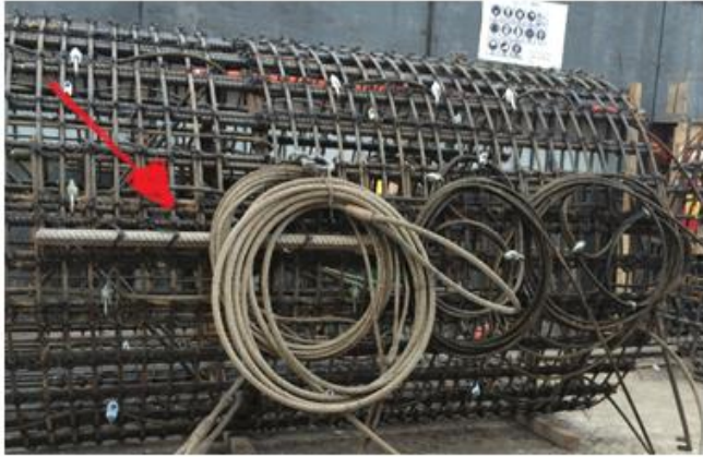
Fig. 3.17, Agujas con Estrobos
