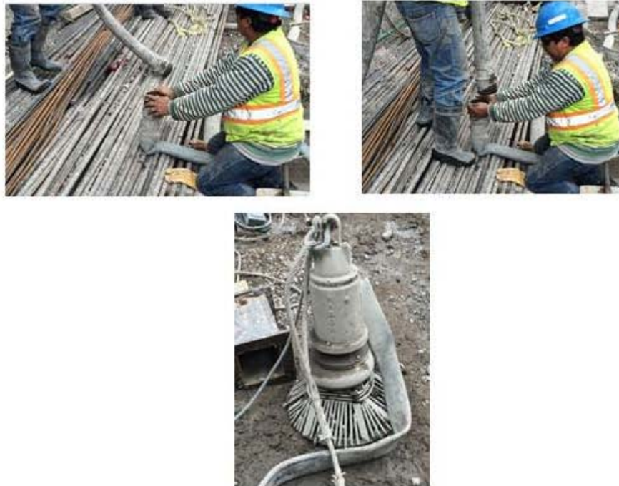
Fig. 4.8. Armado Sistema de Bombeo
