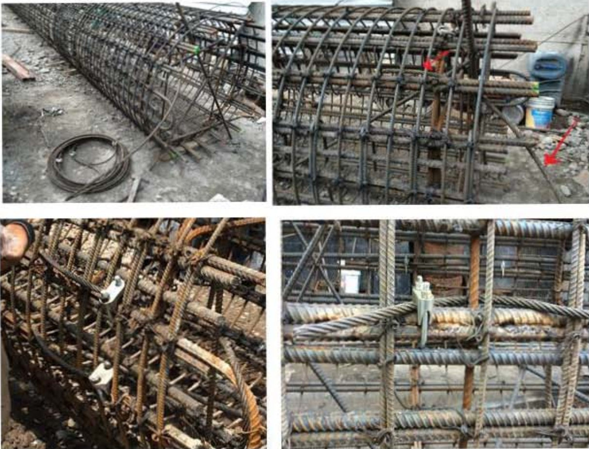
Fig. 3.20, Colocación de Estrobos para Trampeado Final
