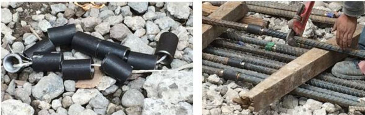
Fig. 1.37, Conectores Lenton
