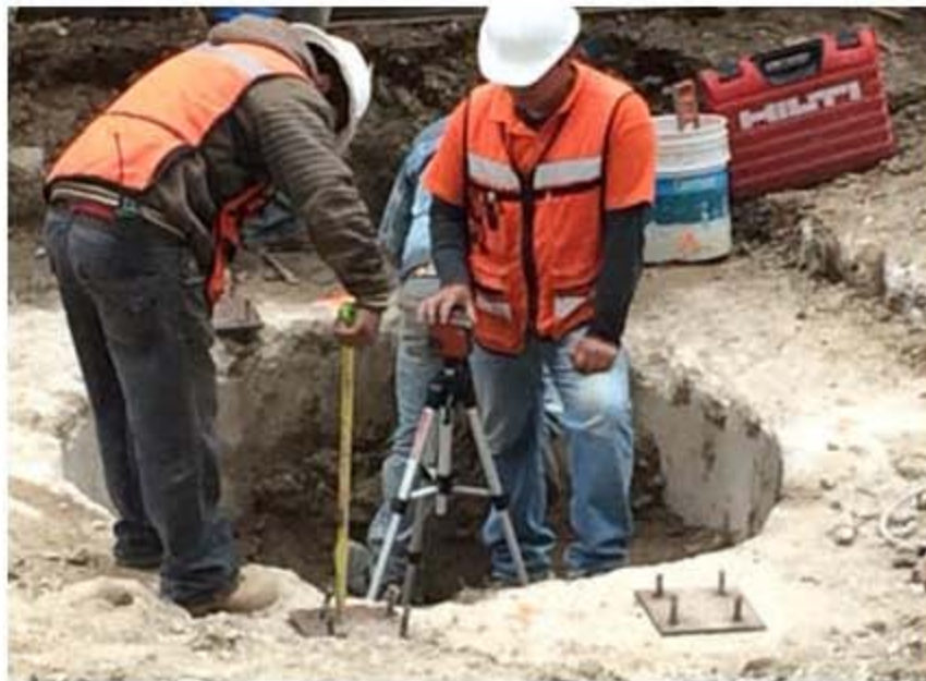
Fig. 1.27.1, Nivelación de las Placas de Apoyo
