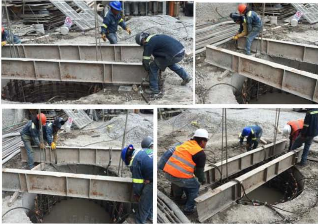
Fig. 3.37, Colocación de Estrosos en las Viguetas
