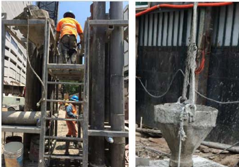
Fig. 4.9, Tolva, Conexión a la Grúa.
