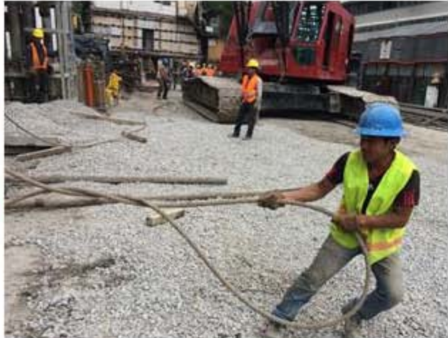
Fig. 3.33, Desenredo de Estrobos
