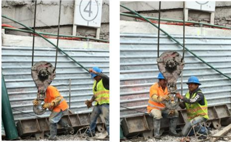
Fig. 3.39, Desconectando el Blancín de la Garrucha
