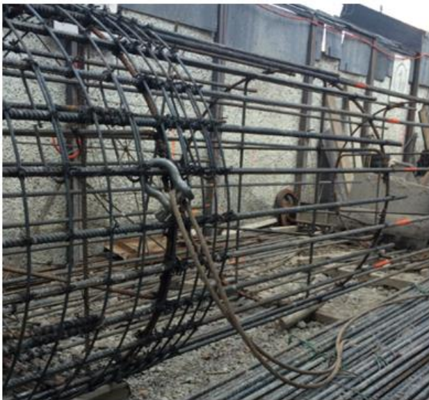
Fig. 3.13 y 3.14, Estrobos y Grilletes
