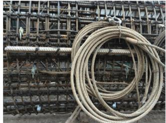
Fig. 3.17, Agujas con Estrobos
