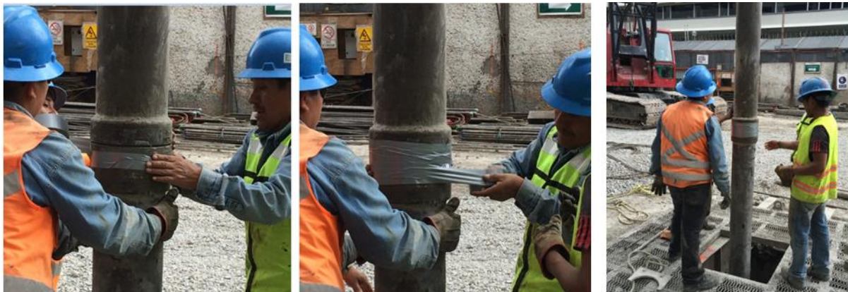
Fig. 4.11, Colocación de Cinta Gafferr
