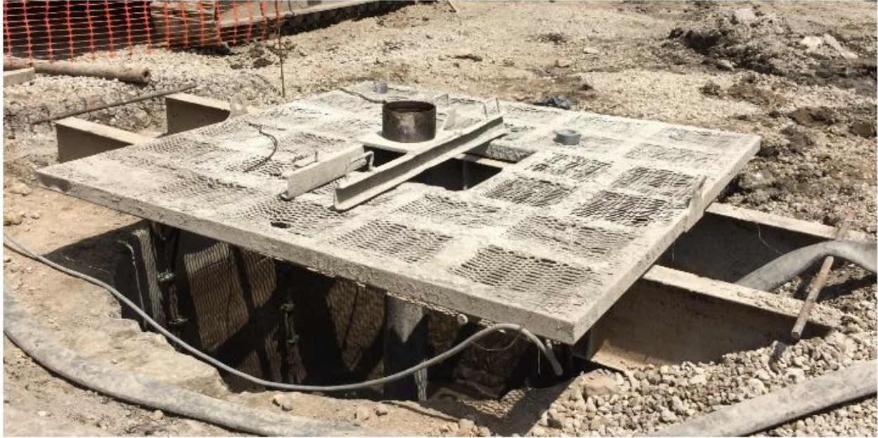
Fig. 4.12, Colocación de la Trampa para sostener la tubería tremie
