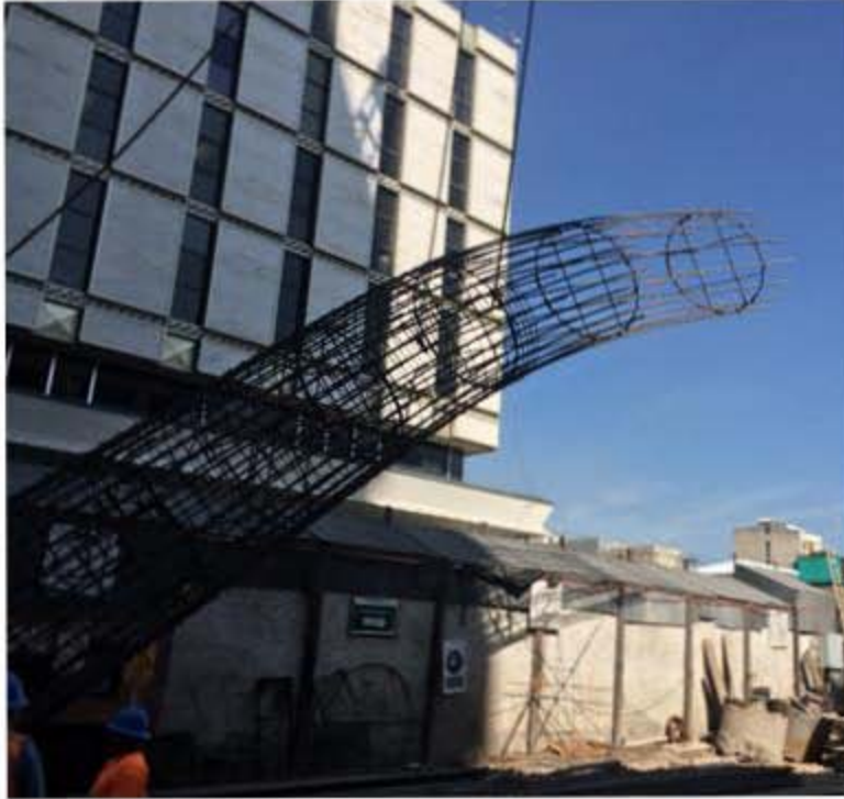
Fig. 3.22, Armado Izado
