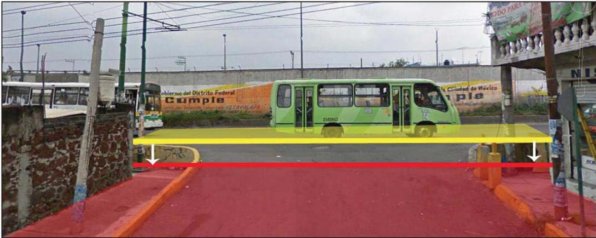
Figura 52. Hundimiento de mínima ocurrencia en la calle Juan de Dios Pesa de la colonia La Era, la deformación ha formado un escalón de 40 cm. La línea en color amarillo corresponde a la superficie original y la de color rojo representa el desplazamiento del terreno, ambas definen el escalón o desnivel (junio, 2014).
