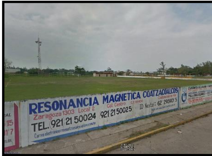
VISTA NORESTE DEL TERRENO
