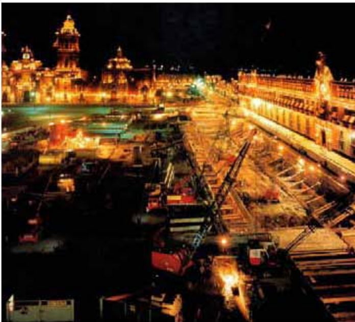
2. Construcción de la estación del metro Zócalo en frente de Palacio Nacional.
