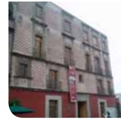
Casa de las Ajaracas. Museo Archivo de fotografía 3 niveles, predomina el macizo sobre el vano.
