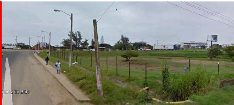
VISTA PONIENTE Conecta con colonia y calle sin pavimentación
