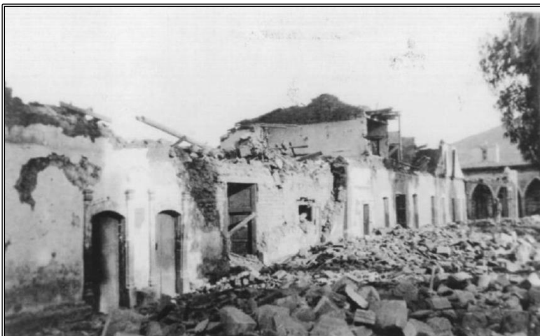
Figura 3.1 Fotografía de los efectos en el pueblo de Acambay, producto del sismo del 19 de septiembre de 1912 (Urbina & Camacho, 1913).
