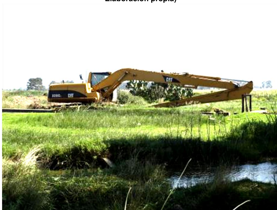
Figura 21. Maniobra manual-mecánica usada esporádicamente para la limpieza parcial de la Laguna Zupitlán. . (Fuente Elaboración propia)
