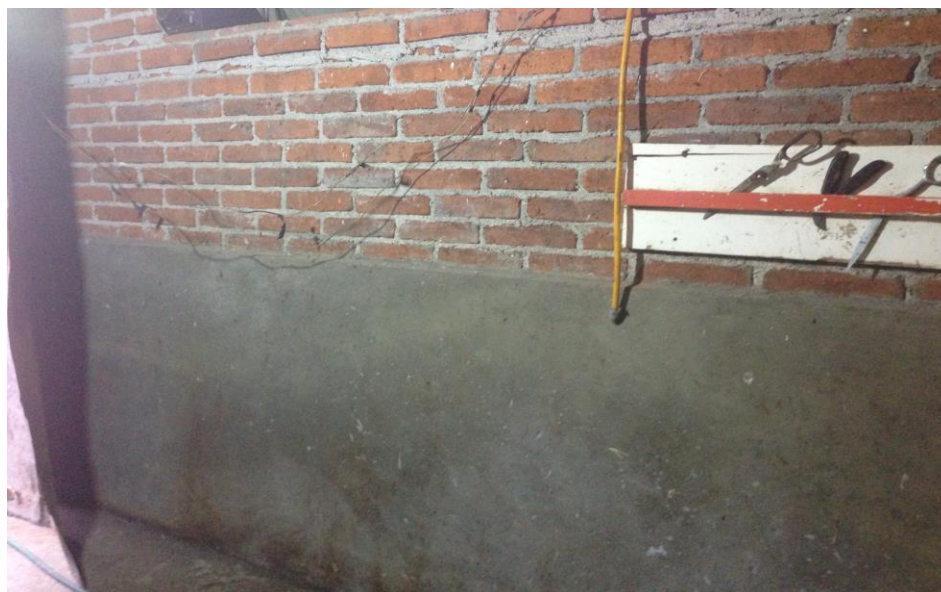
Figura 8. Instalaciones físicas del establecimiento dedicado a la matanza de aves en Tultepec, México.
