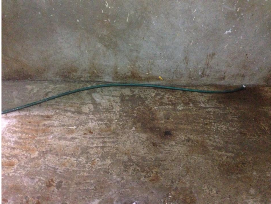
Figura 10. Piso de cemento del establecimiento dedicado a la matanza de aves en Tultepec, México.
