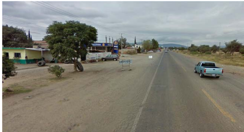
Vialidad 6. Tramo urbano de la carretera 200, dos carriles para doble sentido.
