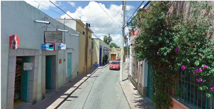
Vialidad 3. Calle terciaria de 1 solo sentido y carril vehicular, banquetas angostas y postes que dificultan el paso peatonal.
