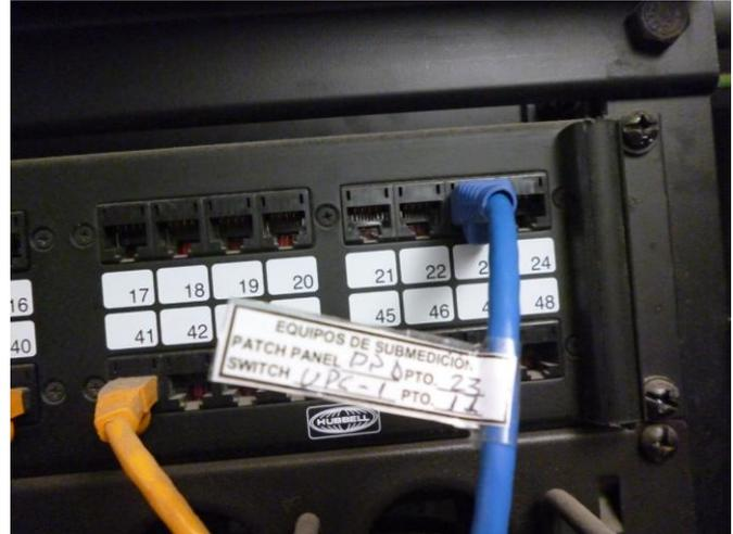
Fig. 53 Conexión de patch cord a switch principal.
