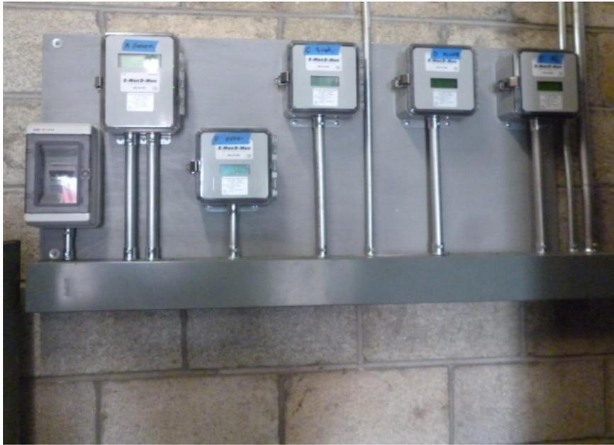
Fig. 46 Fijación de Medidores y tubería.
