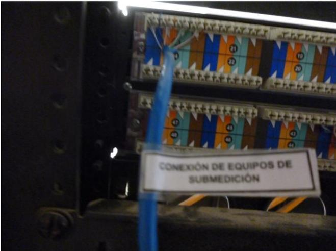
Fig. 52 conexión de cable de red a parte trasera del patch panel.
