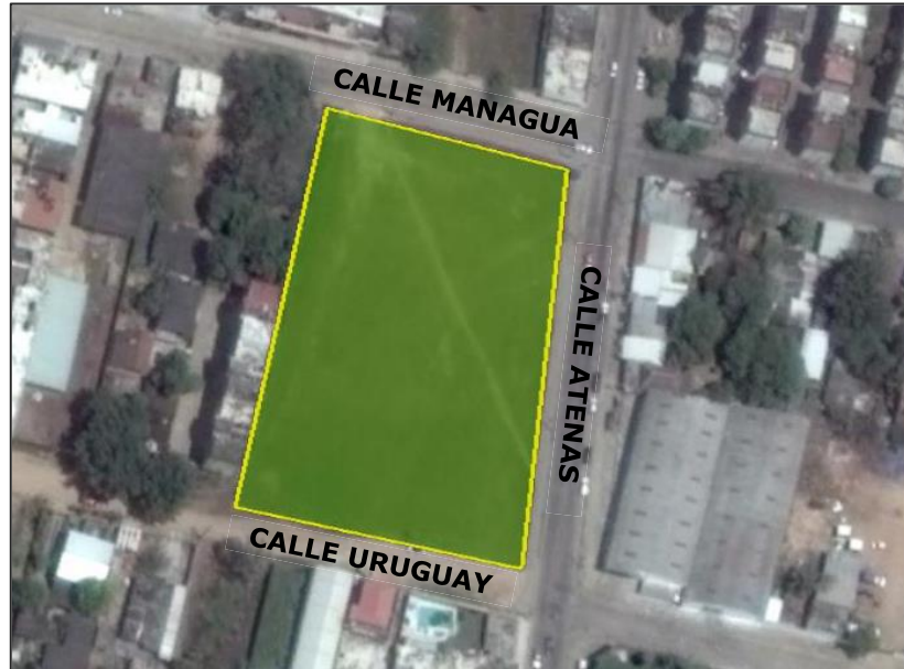
Ilustración VII.2.6 Vista aérea del terreno propuesto 01 con nombres de calles, en la colonia nueva mina de la ciudad de Minatitlán, Ver.
