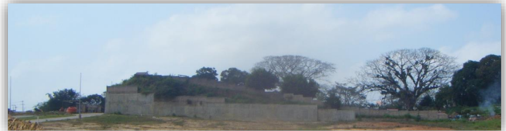
Vista al norte colindando con parte posterior del panteón Municipal
