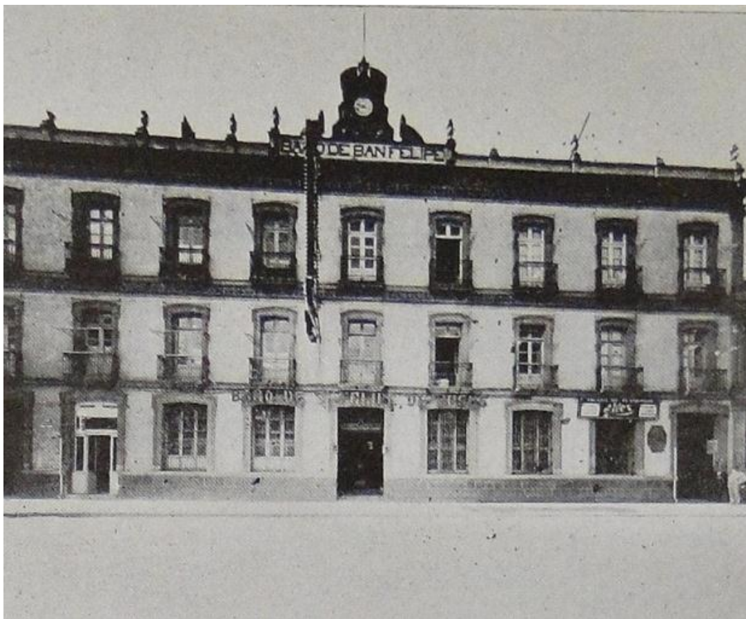
22. Fachada del edificio de los Baños de San Felipe en la calle de Mesones.
