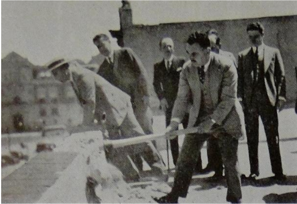
16. El Lic. Aarón Sáenz, Jefe del DDF en 1934, al iniciar las obras de demolición.
