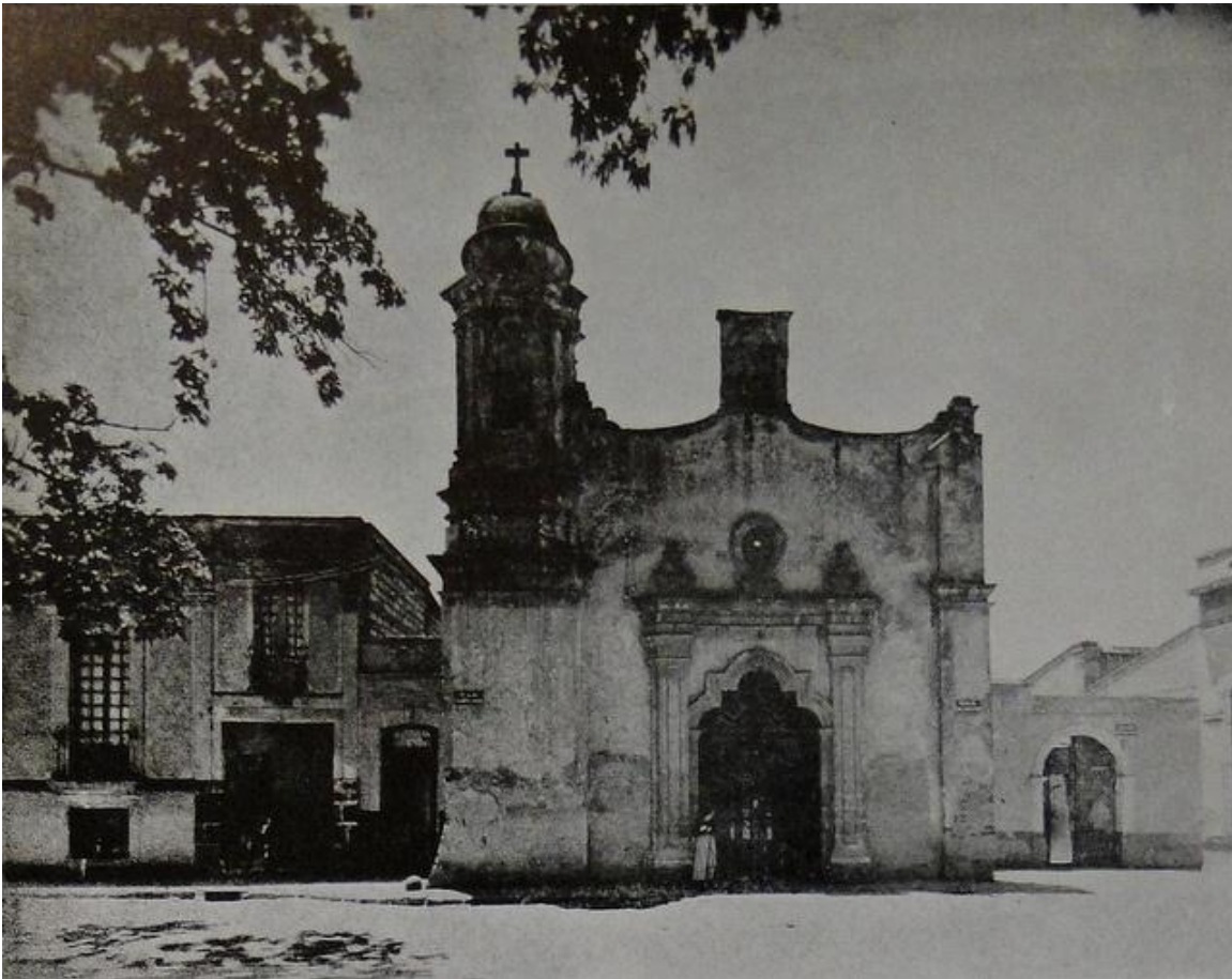
30. Capilla de Tlaxcoaque antes de la intervención.
