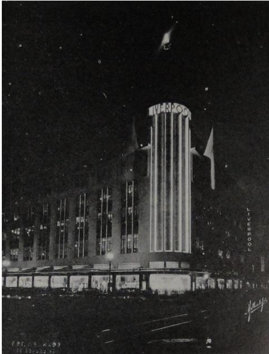
37. La iluminación de la torre del —Puerto de Liverpool”.
