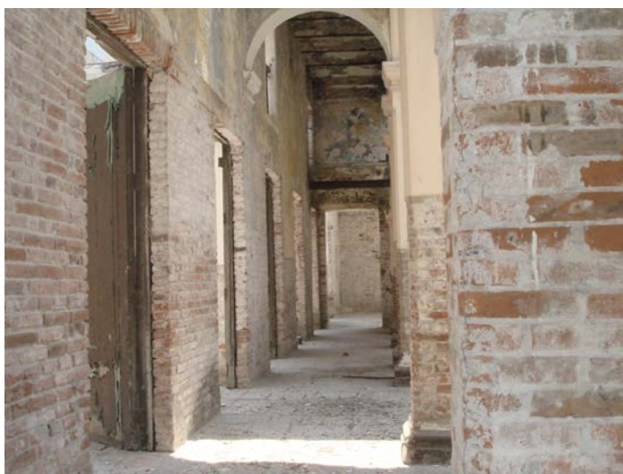
FIGURA 132.- Vista del pasillo del patio central.
