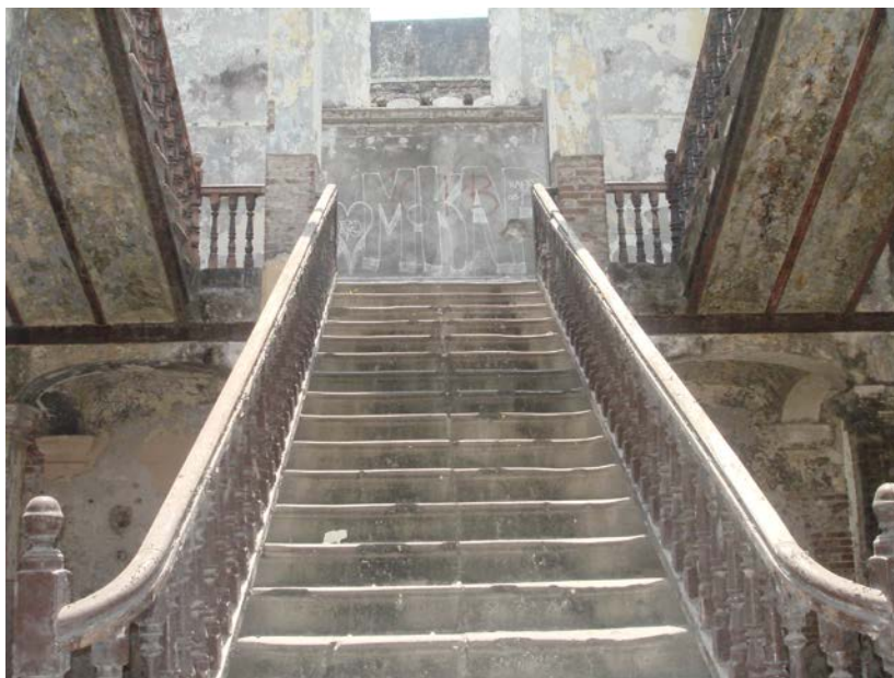
FIGURA 126.- Escalera principal. Año 2009
