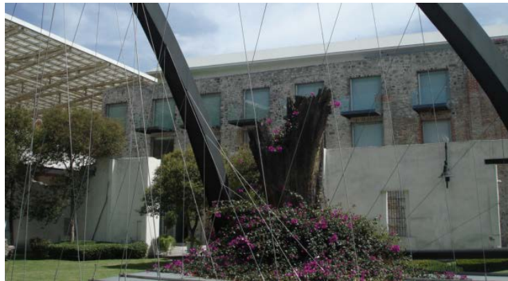
FIGURA 97.- Vista del exterior del Hotel La Purificadora
