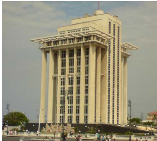
FIGURA 108.- Torre de PEMEX.
