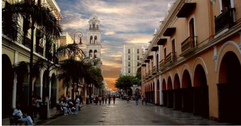
FIGURA 112.- Palacio Municipal y Edificio Trigueros.
