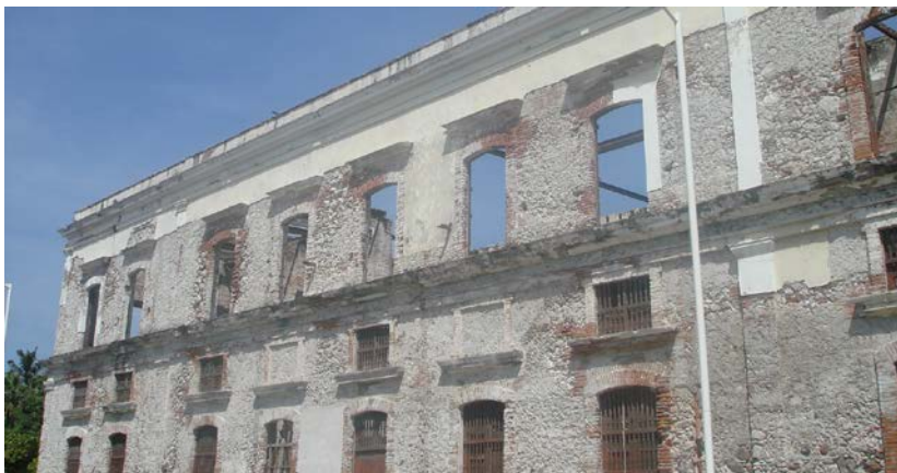
FIGURA 116.- Fachada Miguel Hidalgo
