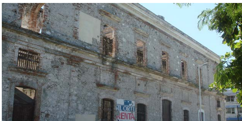
FIGURA 117.- Fachada Lerdo de Tejada.
