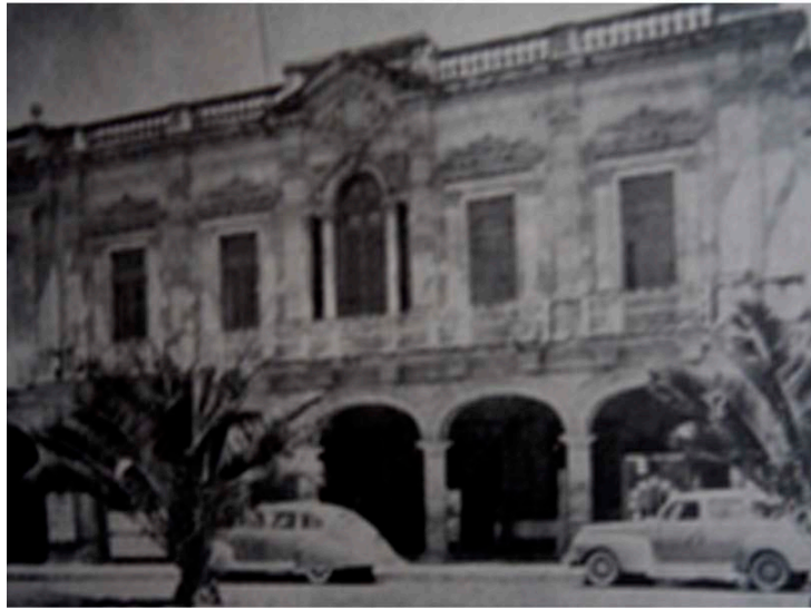
FIGURA 84.- Edificio Normandie en el siglo XIX
