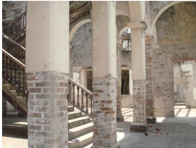
FIGURA 119.- Vista del patio central.
