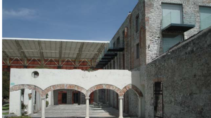
FIGURA 96.- Corredor de La Purificadora
