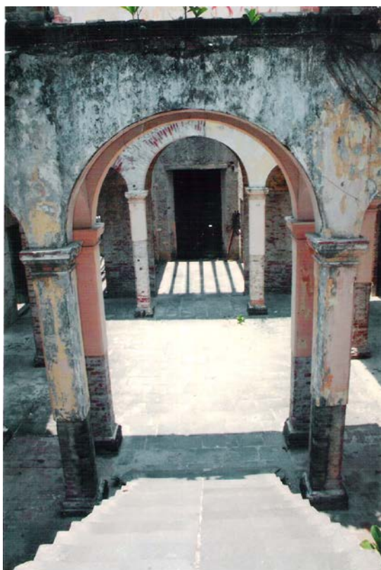
FIGURA 127.- Escalera principal. Año 2006
