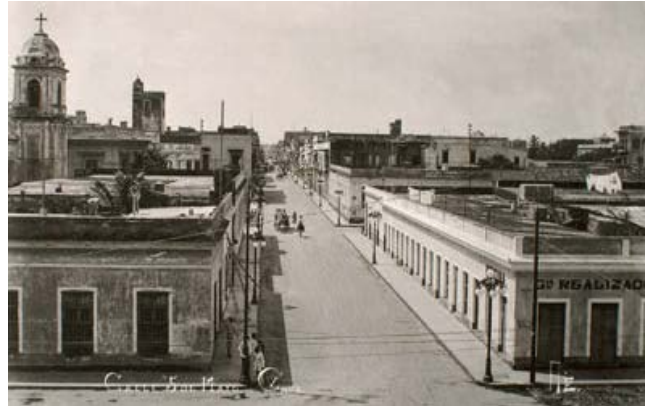
FIGURA 23.- Avenida 5 de Mayo antes llamada Calle de las Damas.
