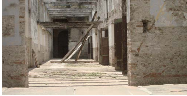
FIGURA 121.- Interior Planta Baja.
