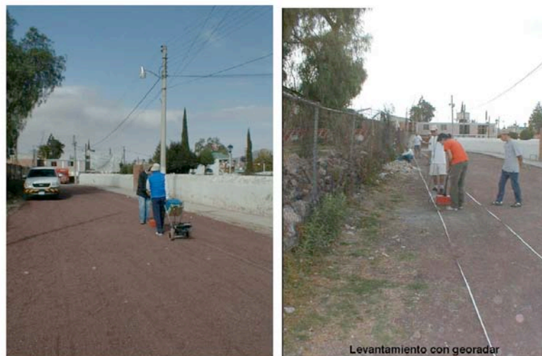
Fig. 160 Estudios de GPR con antena de 400 MHz en la Calle de San Francisco
