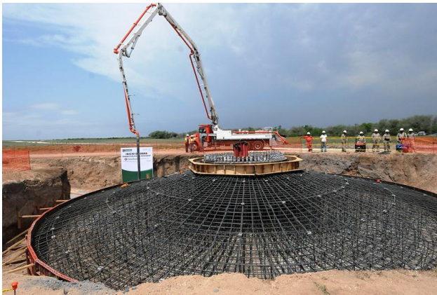
Figuras 4.1 Cimientos para la instalación de un aerogenerador y camino habilitado para la introducción de maquinaria
