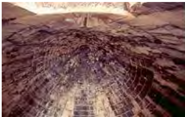
Figura No 2.2.1 a- BÓVEDA DEL TESORO DE ATREO O TUMBA DE AGAMENON MICENAS, GRECIA, 1250 A.C., DIÁMETRO=14.50 M., EL MAYOR DIÁMETRO ALCANZADO CON SILLARES DE PIEDRA SUPERPUESTOS EN VOLADIZO.
