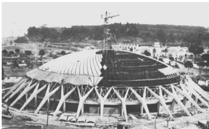
PALACIO DE LOS DEPORTES DE ROMA (1960) – ETAPA DE MONTAJE
