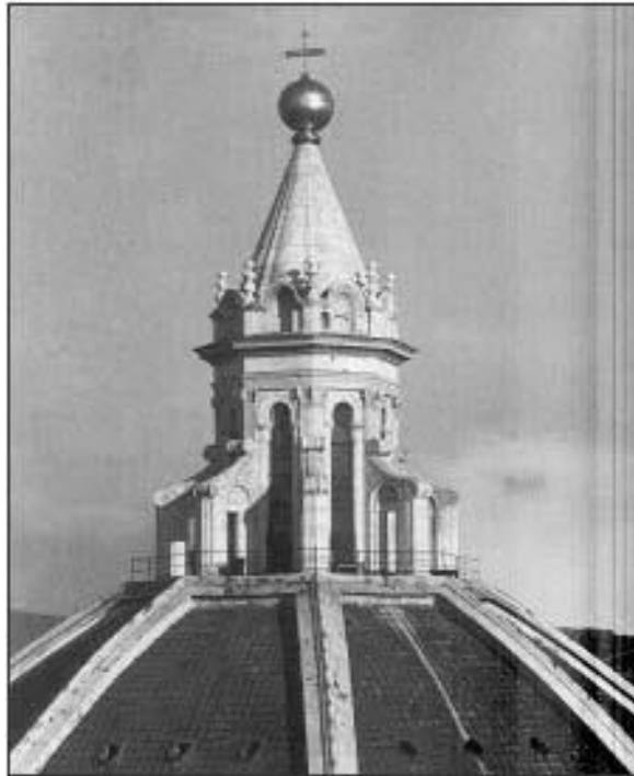
LA LINTERNA DE S. MARÍA DEL FIORE. ACTÚA COMO UNA CARGA VERTICAL IMPIDIENDO LA EXPANSIÓN DE EL CASQUETE.
