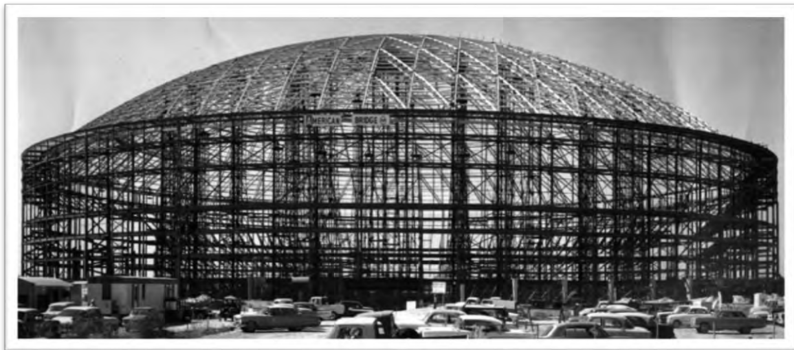
ASTRODOME` DE HOUSTON, TEXAS (1965), PREVIO A COLOCACIÓN DE REVESTIMIENTOS. CUBIERTA A BASE DE UNA RETÍCULA DE ARCOS DE CELOSÍA DE ESTRUCTURA METÁLICA, CON 216.4 M. DE DIÁMETRO. EN 2005 FUNCIONO COMO ALBERGUE TEMPORAL PARA LOS DAMNIFICADOS DEL HURACÁN KATRINA.
