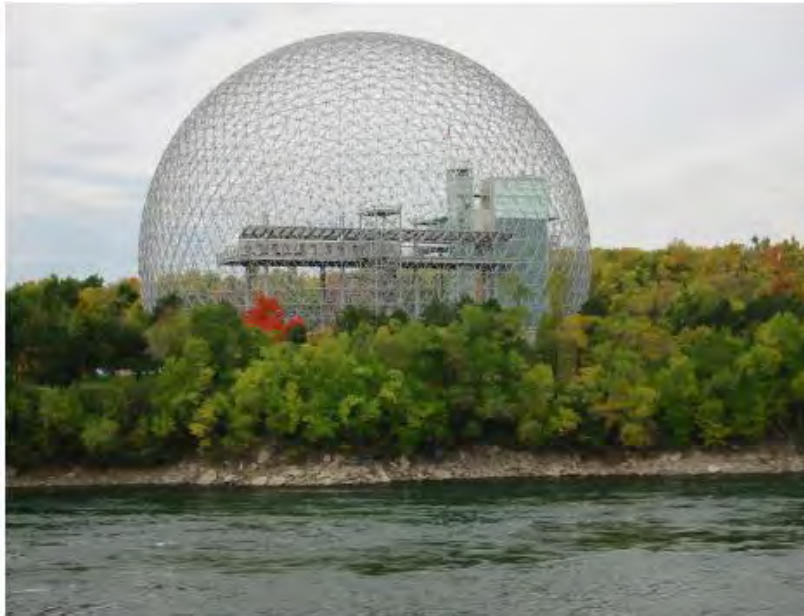
PABELLÓN AMERICANO, MONTREAL (1967), CÚPULA GEODÉSICA DE 76.0 M. DE DIÁMETRO, OBRA MAS NOTABLE DE BUCKMINSTER FULLER QUE RESALTA LA CAPACIDAD DEL SER HUMANO
