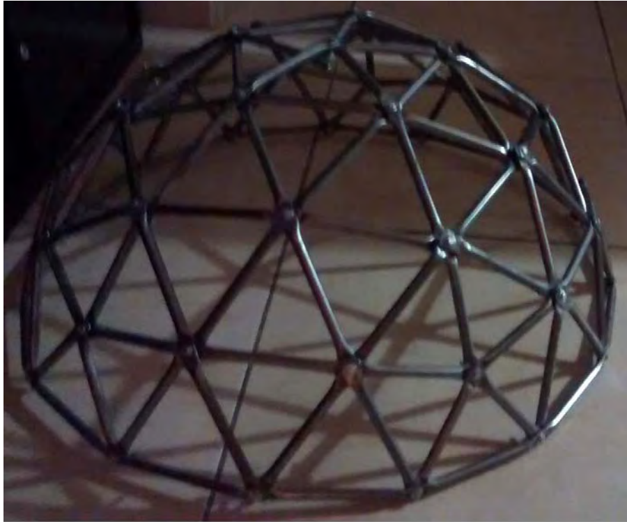
DOMO GEODESICO ELABORADO CON TUBO CONDUIT
