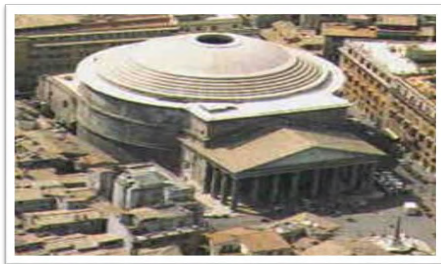
LA CÚPULA DEL PANTEÓN ES SEMIESFÉRICA, FORMADA DE CONCRETO SIMPLE. SE UTILIZARON LADRILLOS EN CAPAS HORIZONTALES, A MODO DE ANILLOS. FUE LA MAYOR CÚPULA CONSTRUIDA EN SU ÉPOCA, CON SUS 43,44 M DE DIÁMETRO, CORONADA POR UN AMPLIO ÓCULO DE 8,9 M QUE LLENA DE LUZ EL ESPACIO INTERIOR
