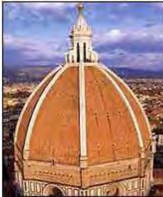
LAS COSTILLAS BLANCAS DE S. MARÍA DEL FIORE CUMPLIENDO COMO ESQUELETO DE LA CÚPULA.
