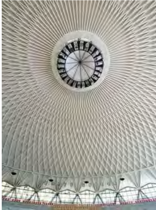
CUBIERTA DEL PALACIO DE LOS DEPORTES DE ROMA, (1960) CON NERVADURAS DE CONCRETO REFORZADO EN MÓDULOS PREFABRICADOS Y MEMBRANA DE FERROCEMENTO, CON DIÁMETRO DE 100.0 M., EL MAYOR ALCANZADO HASTA LA FECHA CON ESTE MATERIAL POR EL ING. PIER LUIGI NERVI (1891-1979).
