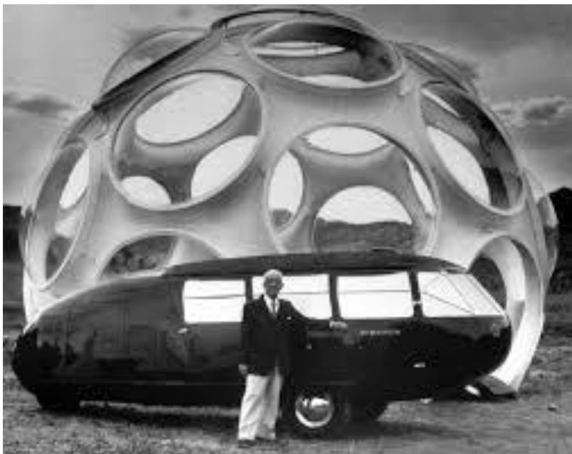
BUCKMINSTER FULLER CON DOS DE SUS CREACIONES: LA CÚPULA 'OJO DE MOSCA' DE 7.3 M. DE DIÁMETRO, CONSTRUIDA CON FIBRA DE VIDRIO, ACERO INOXIDABLE Y PLÁSTICO ACRÍLICO Y EL AUTO 'DIMAXION', VEHÍCULO DE TRES RUEDAS CON CAPACIDAD PARA 11 PASAJEROS (1933)
