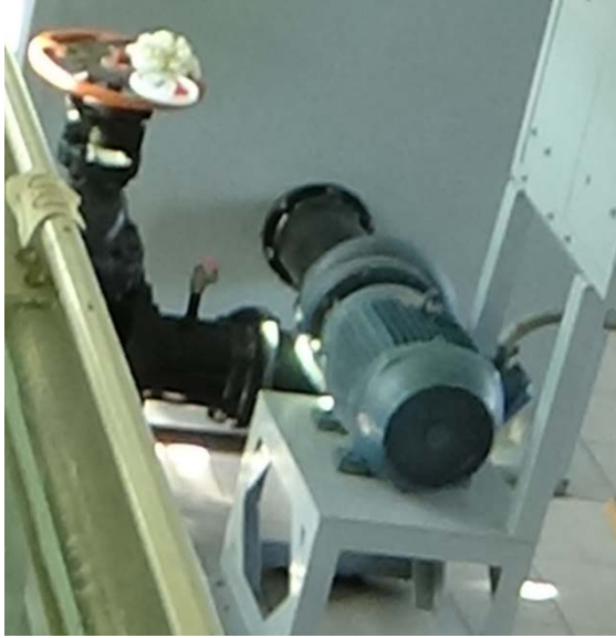
Figura A.3 Bomba que mantiene el flujo de agua en el canal
