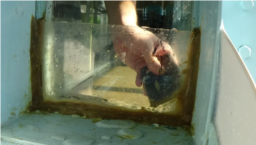
Figura 3.21.- Instlación de vertedor a la salida de canal, para elevar tirante
