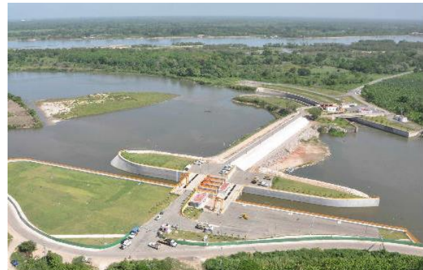
Figura 6 Estructura de control sobre el río Carrizal.
