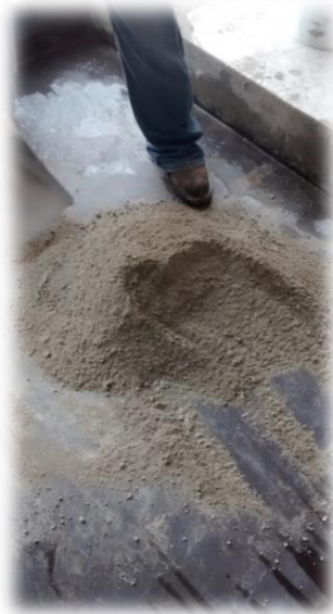
Figura 2.30. Mezcla homogénea de agregado fino y cemento.
