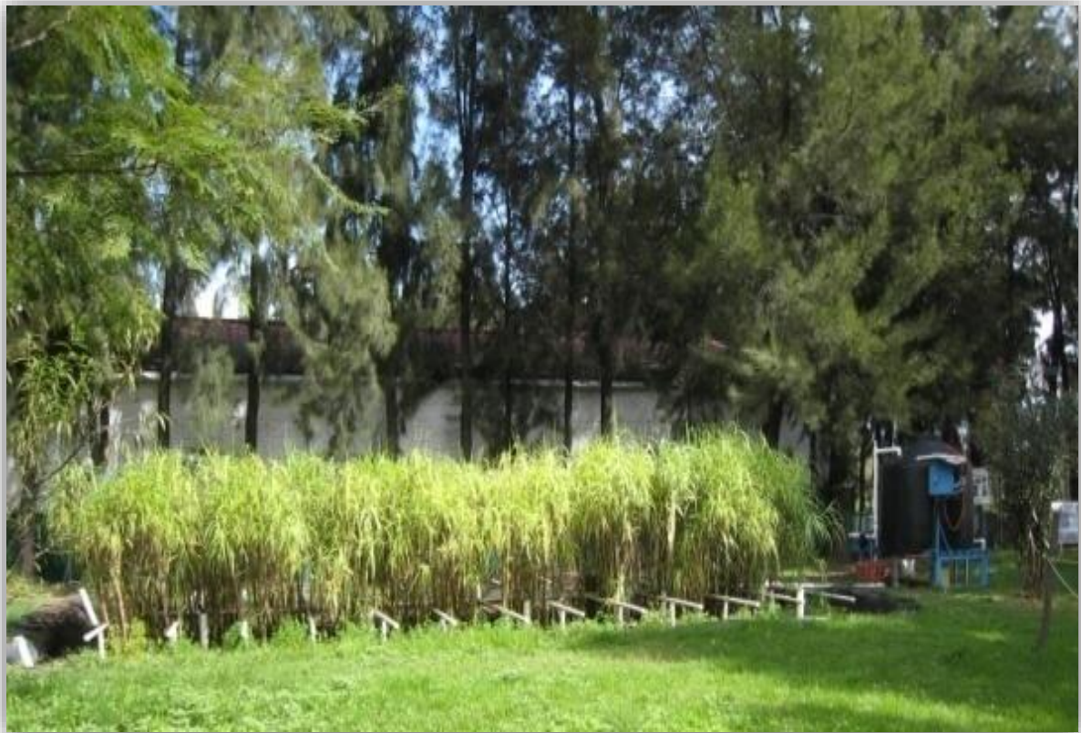
Figura 9. Humedal de flujo subsuperficial de flujo combinado del CIBAC
