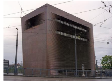
Signal Box, Herzog & De Meuron.
