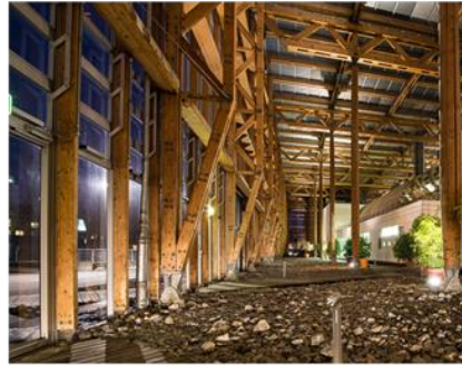
Montantes triangulados, introduce elementos no ortogonales.
