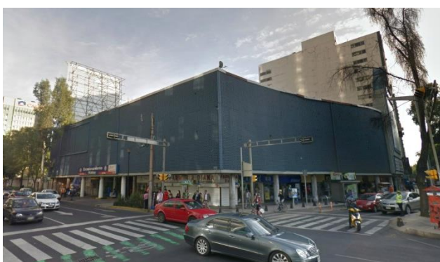
Foto 2. VISTA DEL PREDIO DESDE LA ESQUINA DE AV.PASEO DE LA REFORMA Y CALLE RÍO MISSISSIPPI.
