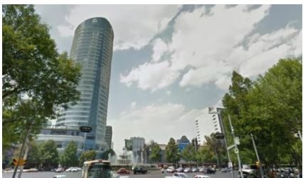
Foto 5. VISTA DEL TERRENO DESDE
