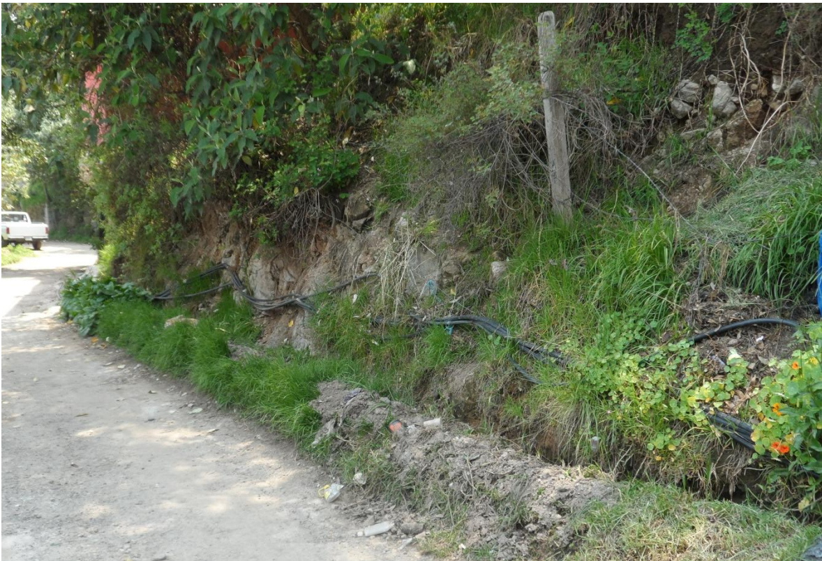
IMAGEN D. Instalaciones para agua potable
